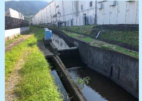
大雨の予報が出された時に事前に堰の倒伏を行う
