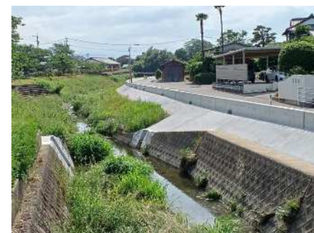
護岸嵩上げの整備
