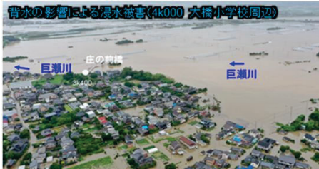
▲R5.7洪水における巨瀬川の浸水被害状況 筑後川の背水の影響で越水している。
