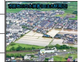
▲R5.7洪水における浸水被害状況
