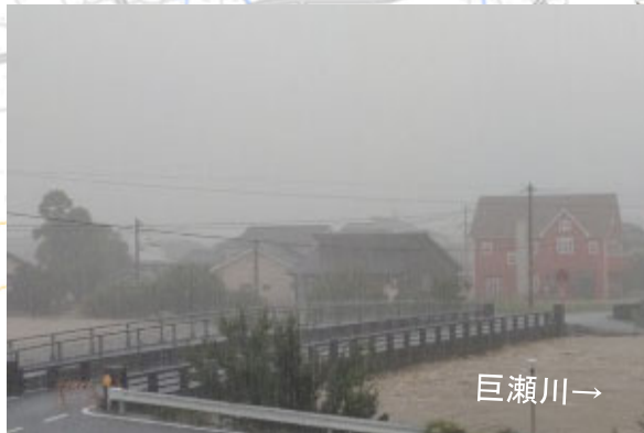
巨瀬川左岸 10k300付近の越水状況
