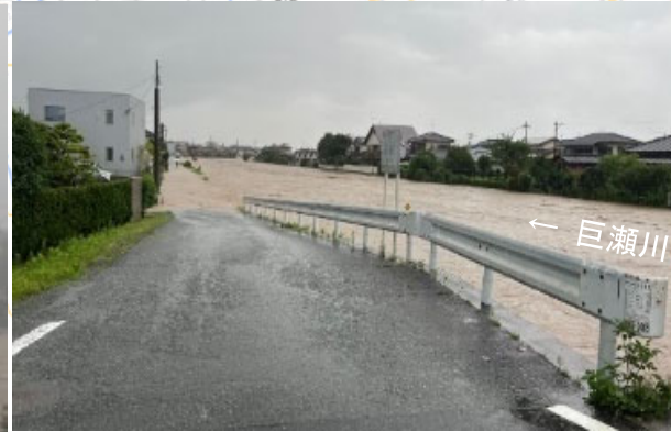
巨瀬川左岸 15k600付近の越水状況
