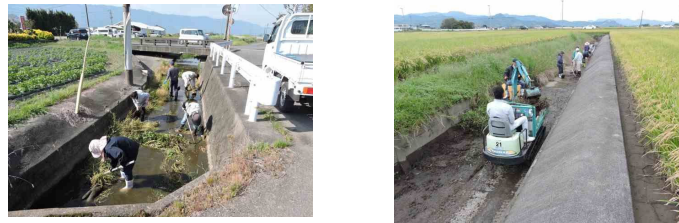
地域による水路等の維持管理
