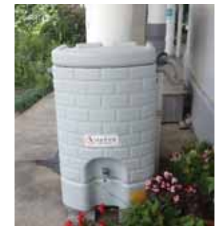
公共施設に設置した雨水貯留タンク
