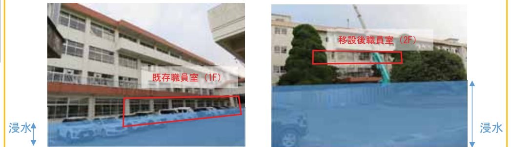
浮羽工業高校外観写真
