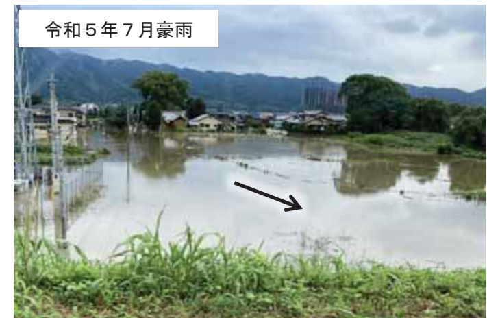
藤町川の溢水状況
