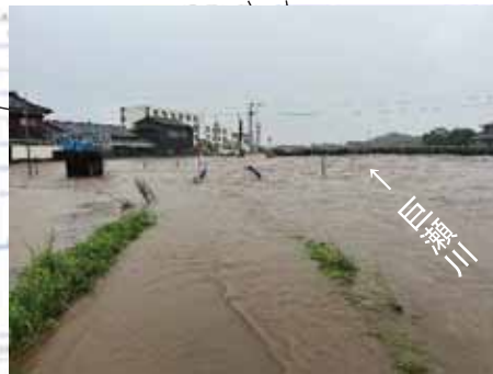
巨瀬川左岸10k000付近の越水状況
