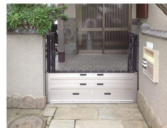
止水板設置事例
