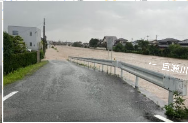
巨瀬川左岸 15k600付近の越水状況
