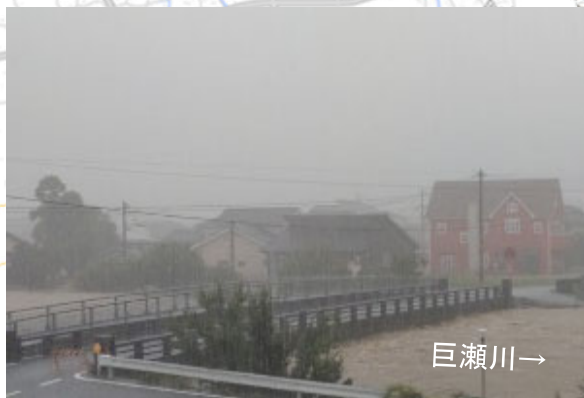
巨瀬川左岸 10k300付近の越水状況
