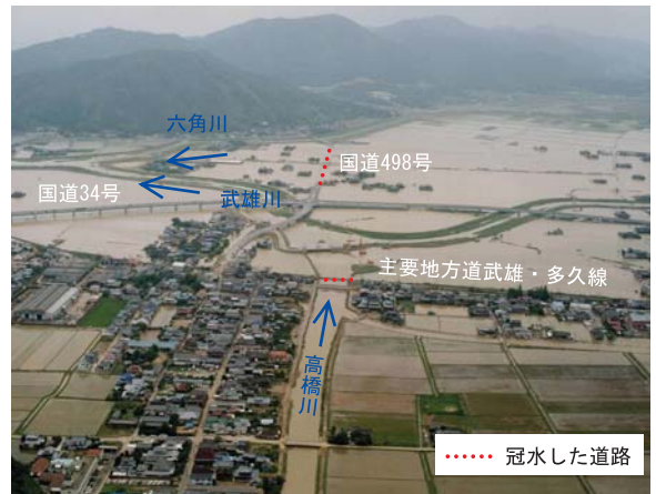
平成2年7月出水の浸水状況
