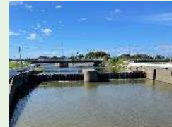
※井竜堰先行排水の様子
