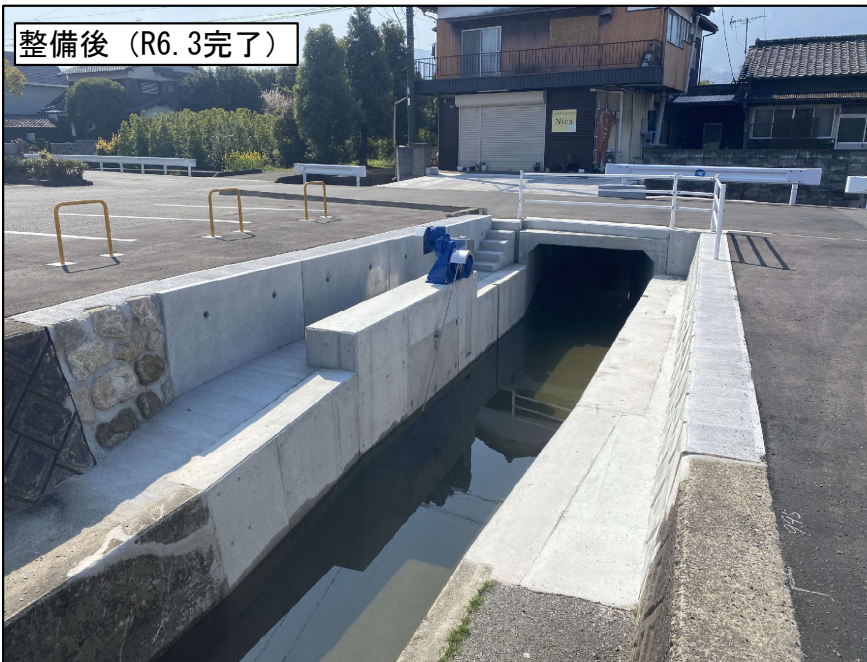
【安免川の河道拡幅（令和6年3月完了）】
