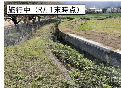
【③ 十八川 護岸かさ上げ】
