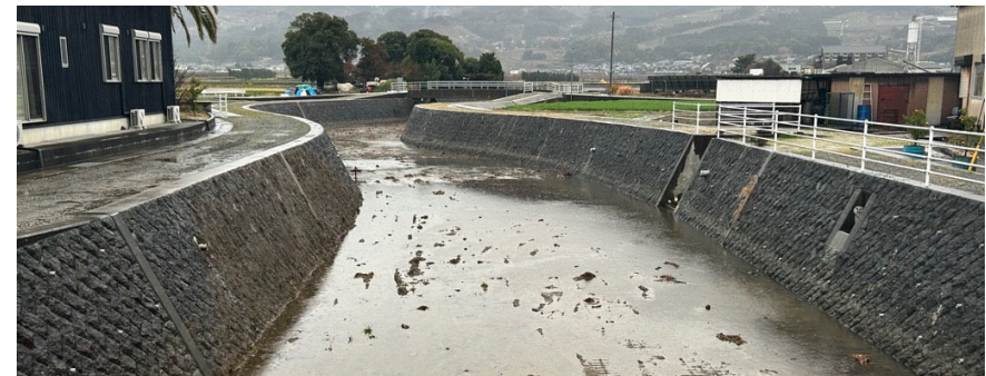
大谷川 浚渫後
