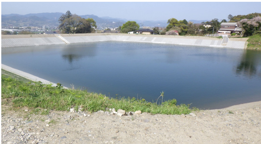
改修後：一の瀬下ため池
