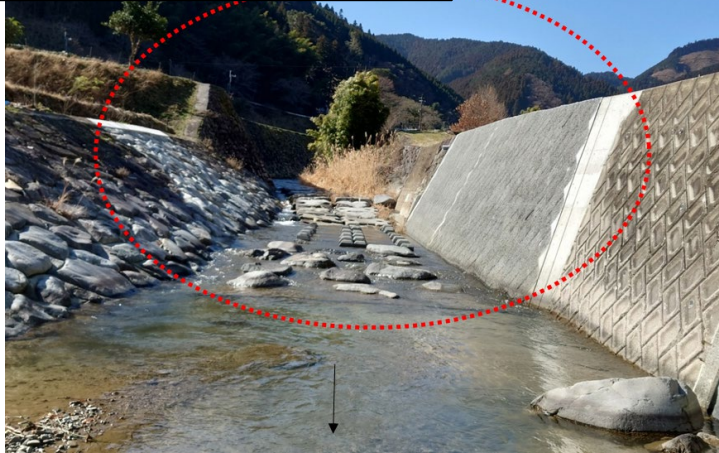
うきは工区（26k660～26k680左岸） ※施工完了
