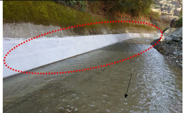
うきは工区（26k100～26k300右岸） ※施工完了
