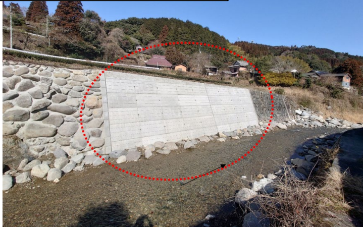
うきは工区（24k900～24k920左岸） ※施工完了
