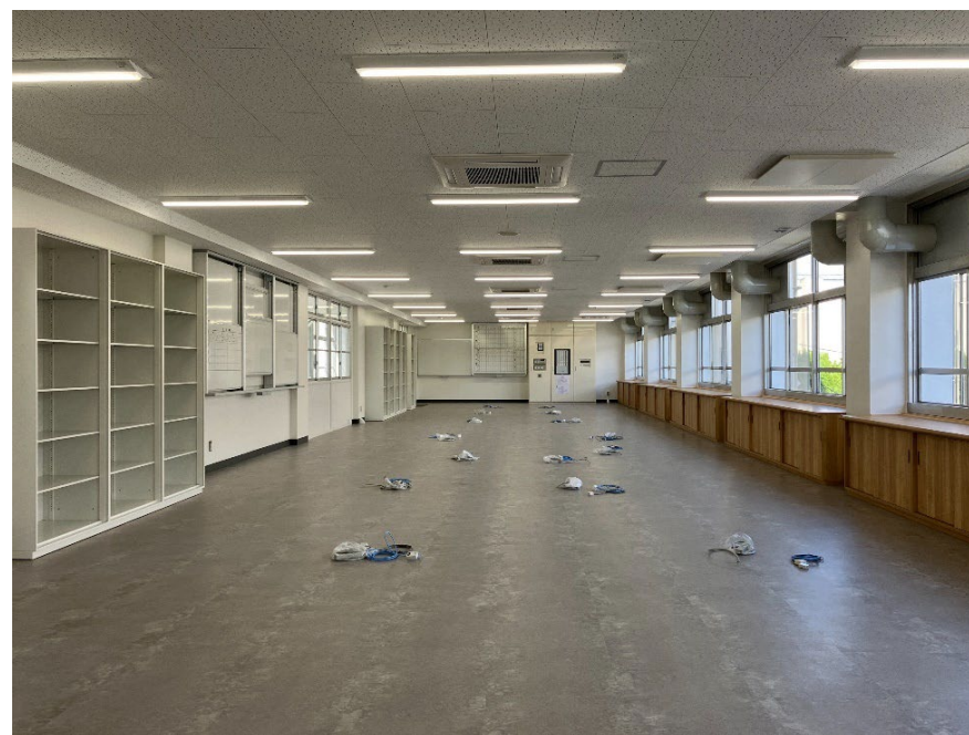
内部写真 改造工事完成（2階職員室）
