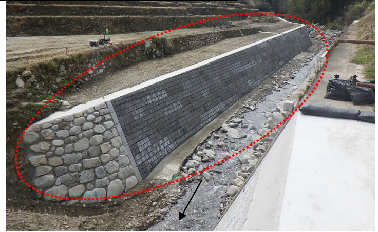
うきは工区（26k100～26k300右岸） ※施工完了
