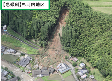
【急傾斜】杉河内地区
