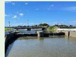
※井竜堰先行排水の様子
