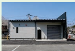
消防団格納庫整備（令和3年完成）
