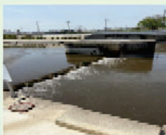
※井竜堰先行排水
