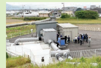
マスプロダクト型排水施設の 試験運転開始
