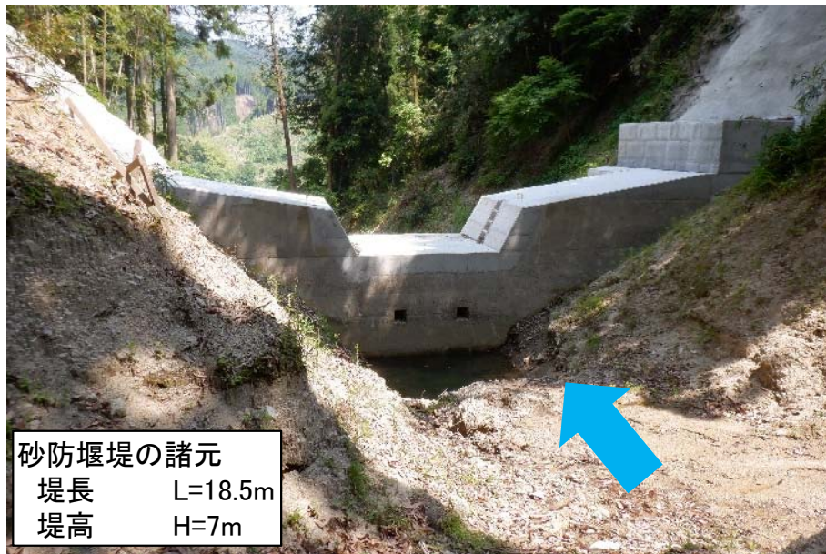
土砂捕捉前 (R2. 5. 28撮影)
