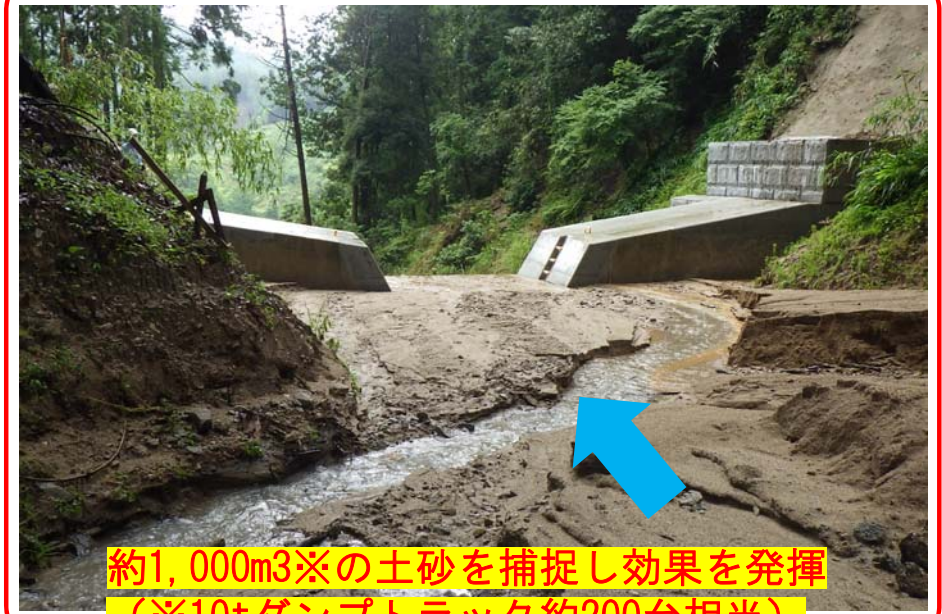
土砂捕捉後 (R2. 7. 8撮影)
