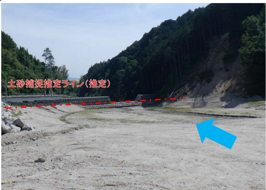
土砂捕捉前 (R2. 6. 2撮影)
