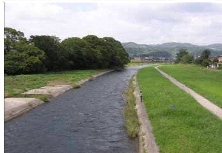
コンクリートで固められた川
