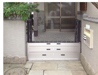
止水板設置事例
