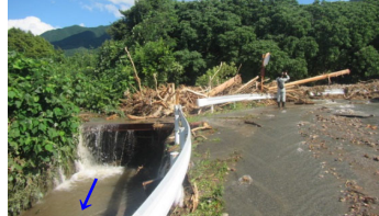
流木による河道閉塞 (冷水川)
