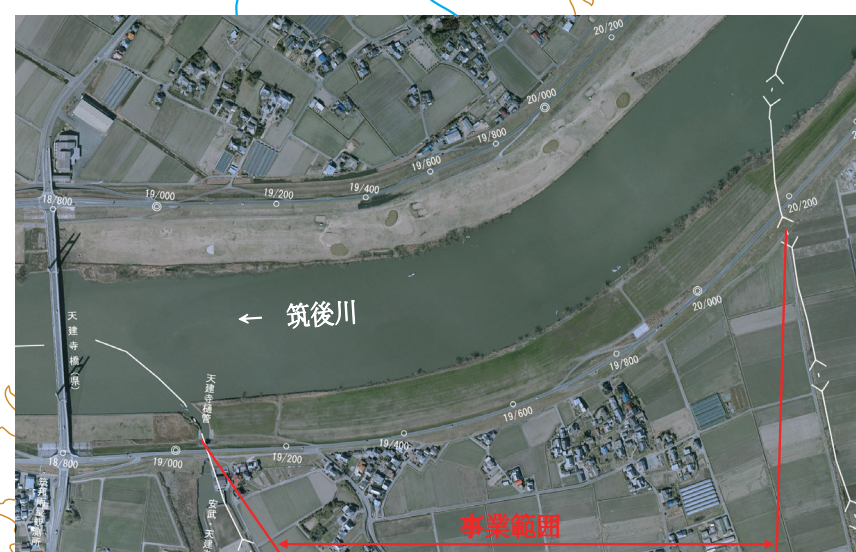
⑦土居外地区堤防と道路の一体整備
