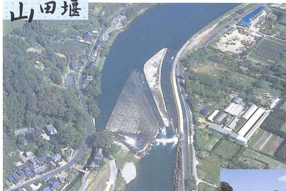
●上空から見た山田堰(朝倉町)
