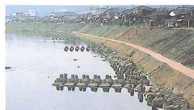
●杷木町昭和橋下流右岸
