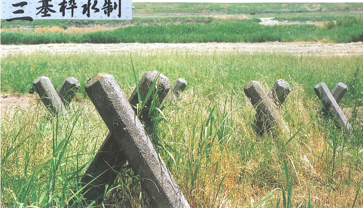
●吉井町朝羽大橋上流付近左岸
