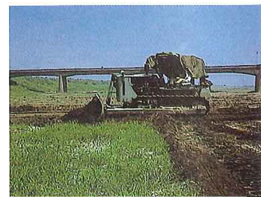
●高水敷の整備（久留米市豆津地先）
