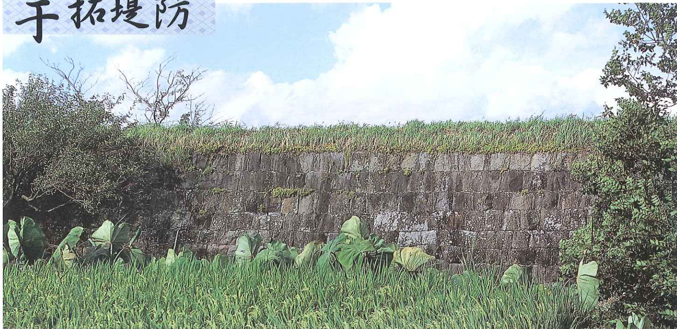
●石積みの干拓堤防
