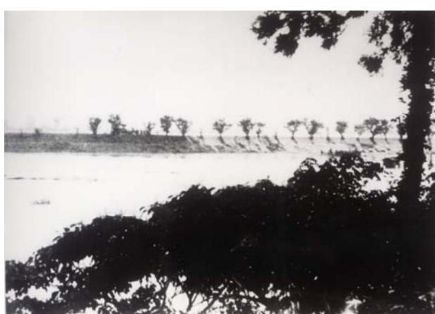
写真 1-2-5 堤防からの越水状況
