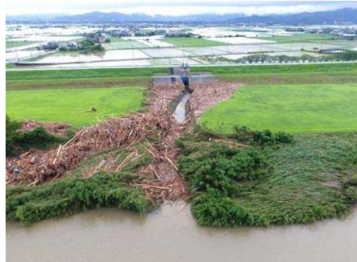
写真4-3-9 猿丸樋管の川表開水路に堆積した流木
