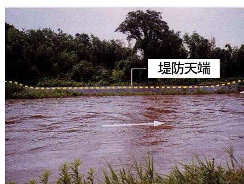
写真2－1－4 堤防越水の危険な状況
