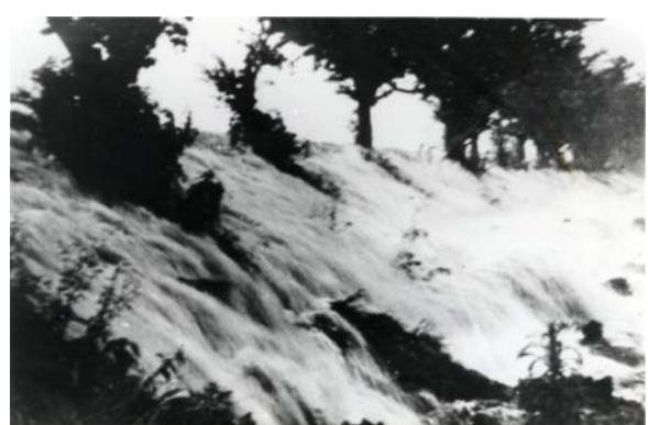
写真 1-2-6 堤防からの越水状況
