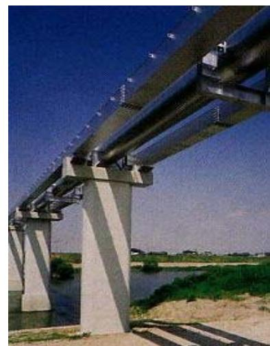
福岡導水路の途中にある思案橋水管橋は、筑後川の水を福岡都市圏まで導水しています。
