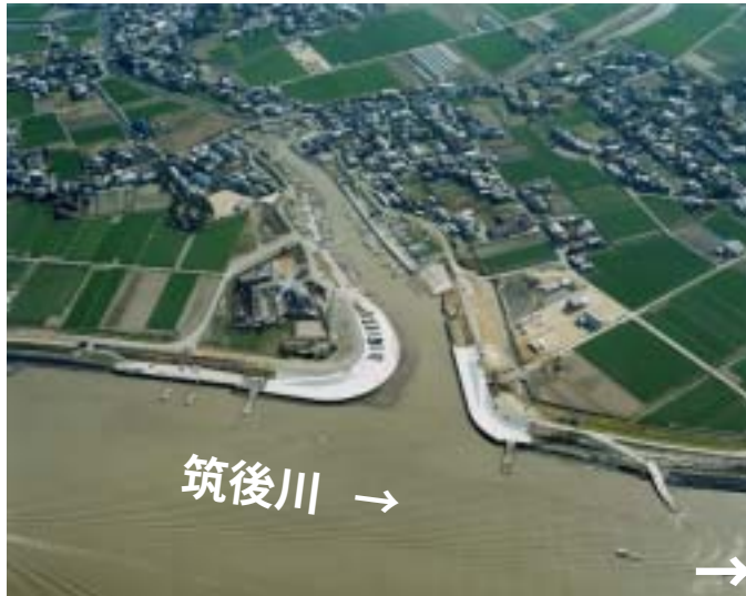
高潮堤防の整備 (大川市新田地区)
