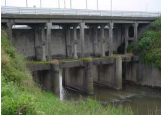
大刀洗水門 (昭和17年設置 ※現在改築工事中)
