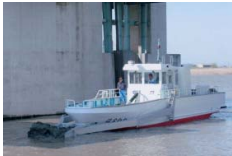
浚渫船によるガタ土の浚渫 (花宗水門)
