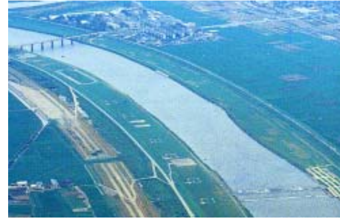
東櫛原引堤前
