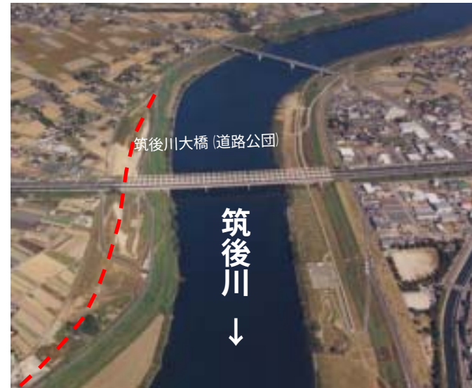
堤防の整備 (久留米市大杜地区)
