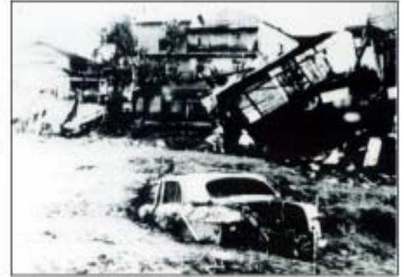
壊滅的な被害を受けた原鶴温泉街
