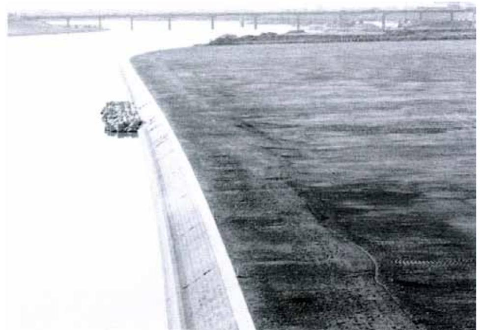
日本住血吸虫病対策として実施された高水敷整備及びコンクリート護岸
