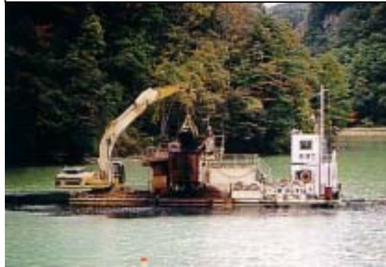
浚渫 (取り除く)
