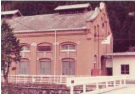
広滝第一発電所 (明治41年～)
