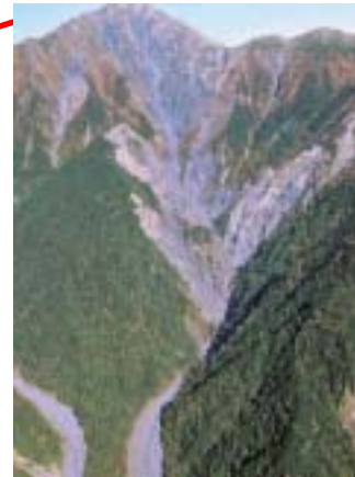
荒川大崩壊地
