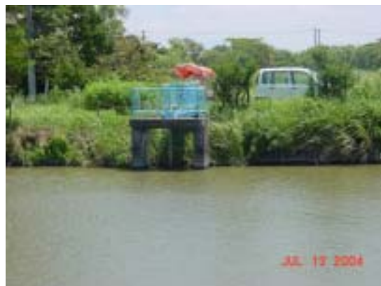
⑬-2 [圃場整備水路] (新) 二十三夜樋管
