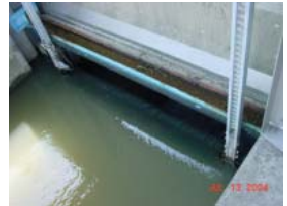
③-2 [県営徳富線] 小松樋管 越流 H=0.08\text{m}
