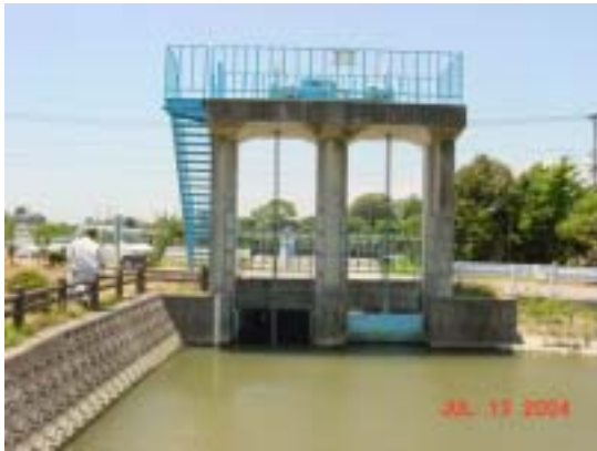
⑭-1 (県営曽根線) 笛ノ橋樋管全景
