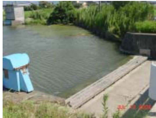
①-2 [水機構大詫間線] 高田樋門余水吐
