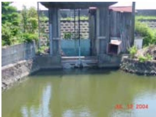
⑦ [圃場整備水路] 崎村集落樋管
