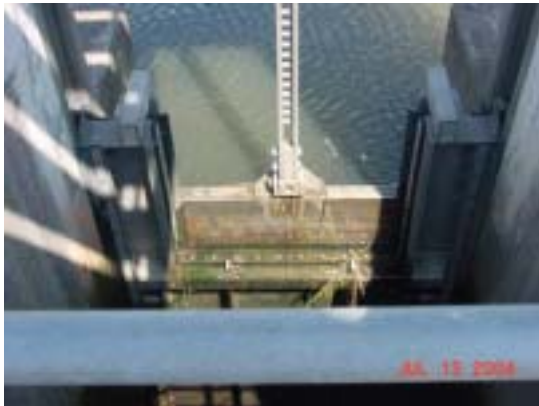
①-1 [水機構大詫間線] 高田樋門
