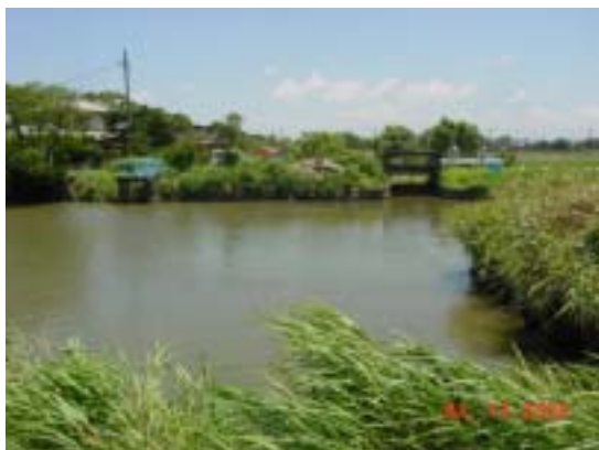
⑬-1 [圃場整備水路] 二十三夜樋管全景
