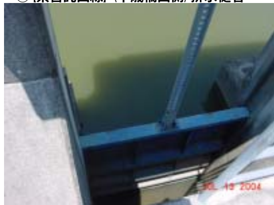
⑪ [圃場整備水路] (古賀橋上流西側) 排水樋管
