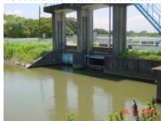
⑫ [県営託田線] 託田入江1号樋管
