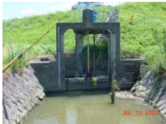
⑧ [県営託田線] (千歳橋西側) 排水樋管
