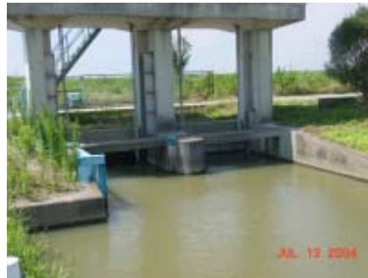
③-1 [県営徳富線] 小松樋管全景
