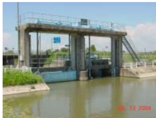
⑤ [国営千代田線] 1号制水門
