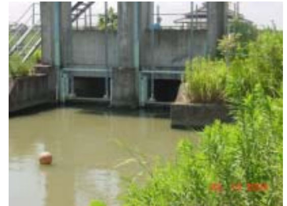
②-1 [国営諸富線] 佐賀江排水樋門全景
