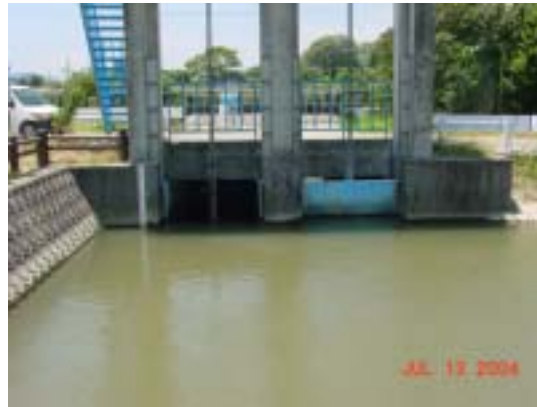
⑭-2 (県営曽根線) 笛ノ橋樋管排水状況
