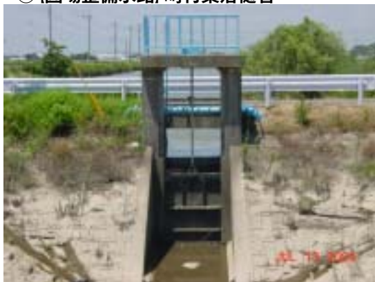
⑩ [県営託田線] 1号制水門
