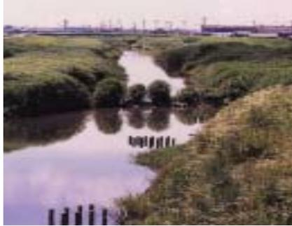
城原川には、「草堰」と呼ばれる堰が13箇所存在しています。この「草堰」は、川の低水路部に木杭を打ち、雑木や草等を置くことによって、下流への流量を確保しながら河川水の有効利用とする一方、洪水時には流失するような構造となっていました。しかし近年では、水利用重視の観点から草堰の上流に石を置いたり、ビニールで覆ったりしているため、洪水の流下阻害となっています。
