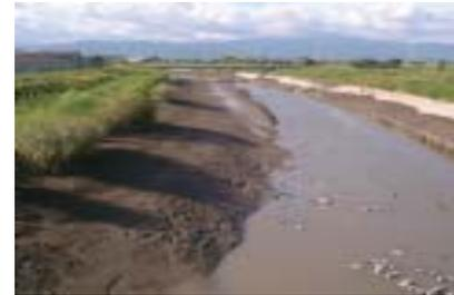
城原川下流は干満差約6mの有明海の潮の影響により、満ち潮の時に運んでくるガタ土が底に堆積しています。川底を掘っても、数年後には、掘る前の状況にもどってしまいます。
