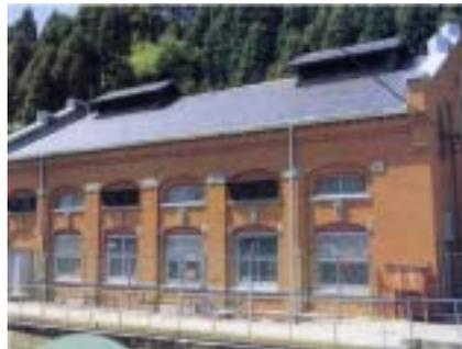
明治41年、九州で初めてできた発電所です。現在も十分発電所として機能しており、タービン3基が約1500kWの発電を行っています。開所にあたっては、煉瓦157万個、セメント4万2千樽を使う大工事だったといわれています。
