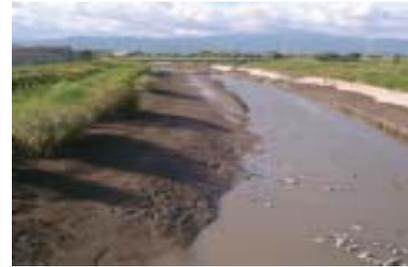
城原川下流は干満差約6mの有明海の潮の影響により、満ち潮の時に運んでくるガタ土が底に堆積しています。川底を掘っても、数年後には、掘る前の状況にもどってしまいます。
