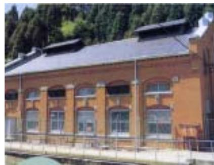
明治41年、九州で初めてできた発電所です。現在も十分発電所として機能しており、タービン3基が約1500kWの発電を行っています。開所にあたっては、煉瓦157万個、セメント4万2千樽を使う大工事だったといわれています。
