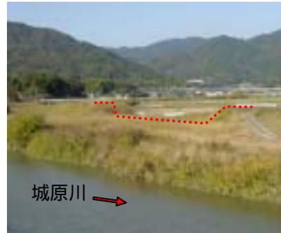
城原川上流部には野越と呼ばれる、洪水を一挙に下流に集中させないために一部分の堤防を低くし、田畑に湧水させる乗越堤が9ヶ所現存します。
