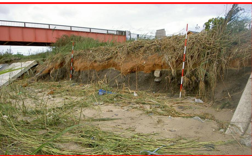
【筑後川右岸:6k700付近(昇開橋上流)】
