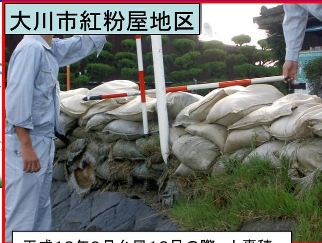
平成18年9月台風13号の際、土嚢積により浸水を防いだ
