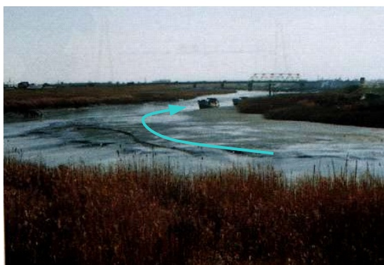
写真 2-1-3 ガタ土の堆積状況（佐賀市）
