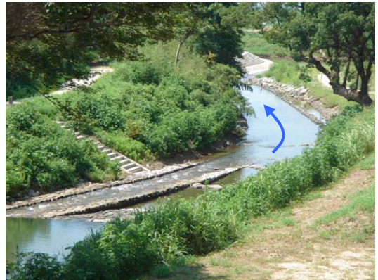
写真 2-2-17 二の井手堰の魚道
