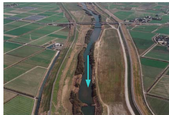
写真 2-2-13 中流部河岸の様子
