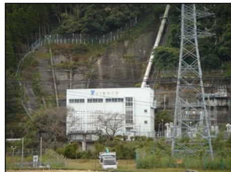
写真 2-2-4 鮎の瀬発電所
