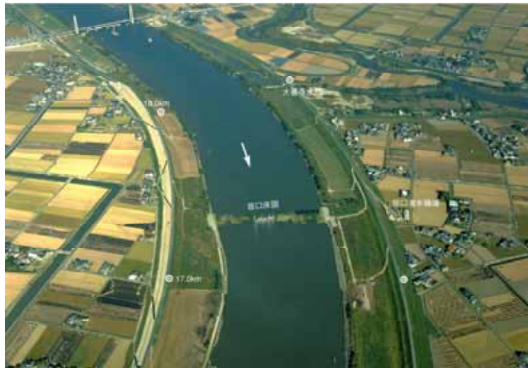
写真4-2-4 坂口床固付近(みやき町)
