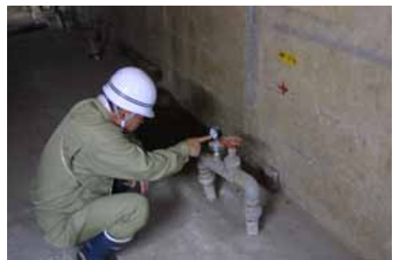
写真4-3-2 ダム等施設の点検
