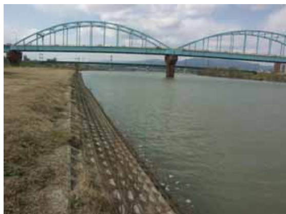
写真4-2-9 宮ノ陣橋上流付近の河岸 (久留米市)
