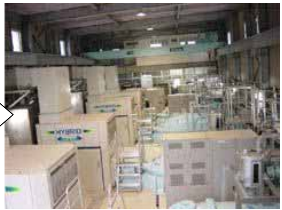
更新後 (排水機場)
