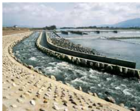
写真4-2-6 魚道のある堰 (恵利堰: 筑後川)
