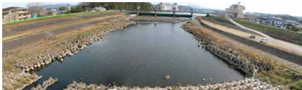
写真5-4-3 整備前の隈川（日田市）
