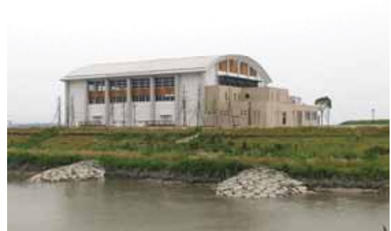
写真4-3-13 久留米西部河川防災ステーション(久留米市)
