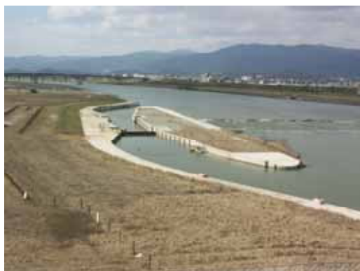
写真4-3-14 整備中の小森野床固の 閘門（久留米市）
