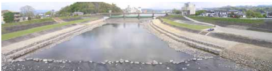
写真5-4-4 整備後の隈川（日田市）
