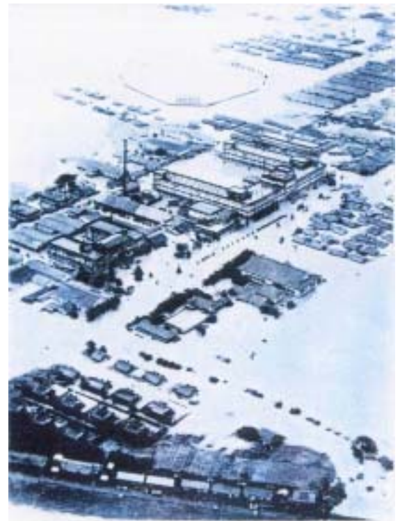
久留米大医学部付近の浸水状況
