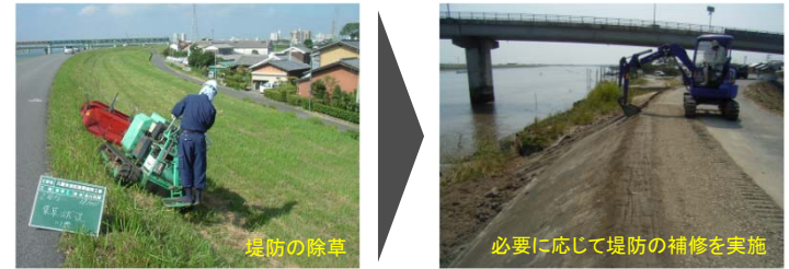
日常的な施設点検整備の実施
