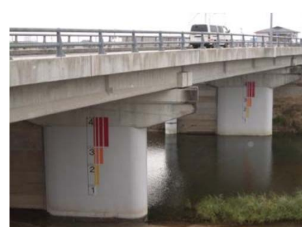
城原川に設置した水位危険度レベル (佐賀県神埼市)
