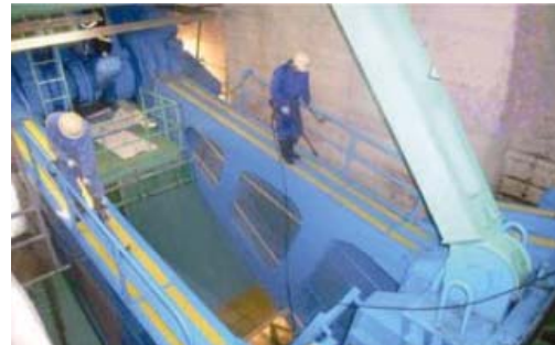
機械設備の点検
