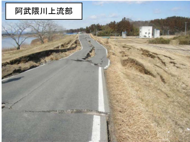
地震による堤防の被災状況
