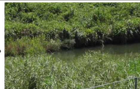
現在の施工箇所の状況（H26.8）
