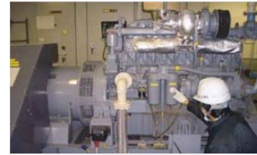
電気設備の点検
