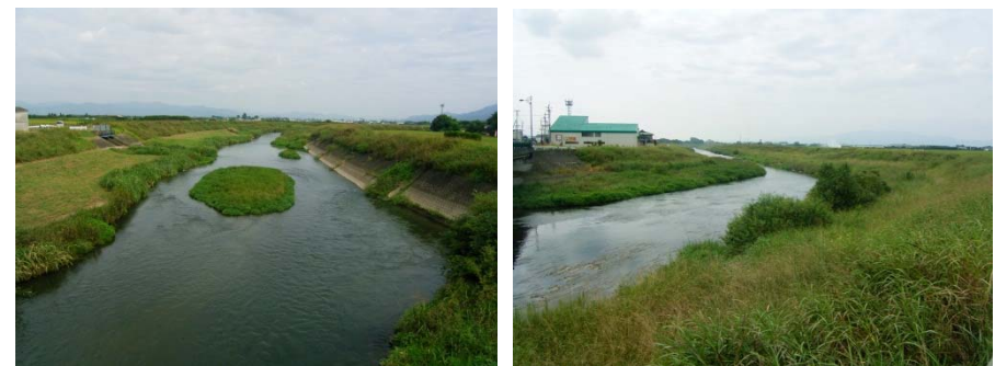
施工後の大橋～川崎橋付近の様子(H26.9)
