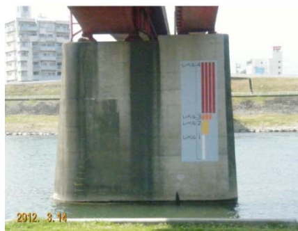
筑後川に設置した水位危険度レベル (福岡県うきは市)
