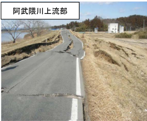
地震による堤防の被災状況
