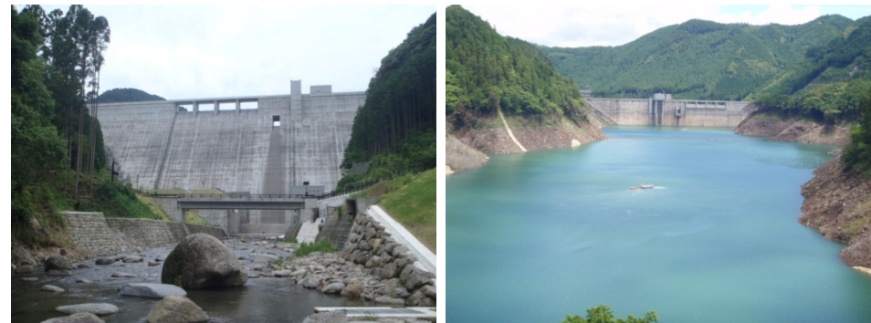
大山ダム堤体
