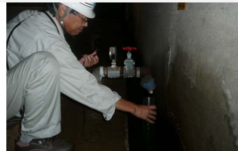
堤体(漏水量)の観察
