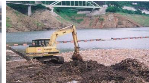
流木塵芥処理の状況
