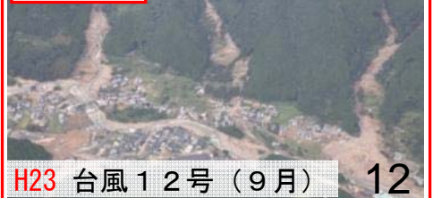
和歌山県東牟婁郡那智勝浦町那智川支川 土石流発生
