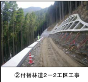
②付替林道2-2工区工事 平成27年3月31日撮影 起点側から終点側を望む
