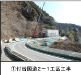
①付替国道2-1工区工事 平成27年3月31日撮影 起点側から終点側を望む
