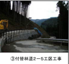
③付替林道2-5工区工事 平成27年3月31日撮影 起点側から終点側を望む
