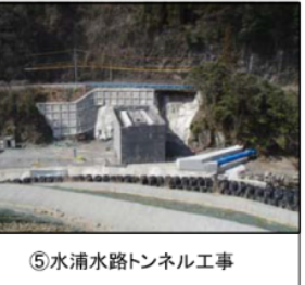
⑤水浦水路トンネル工事 平成27年3月31日撮影 水路トンネル(呑口)を望む
