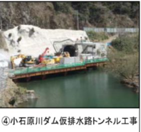
④小石原川ダム仮排水路トンネル工事 平成27年3月31日撮影 吐口(下流)側から上流側を望む
