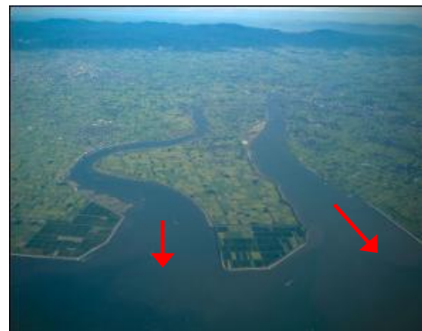
下流部(河口付近)
