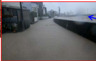
花月川左岸3k800 浸水状況(堤内地の状況)
