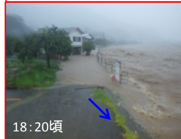
花月川右岸7k600 溢水状況(上流を望む)
