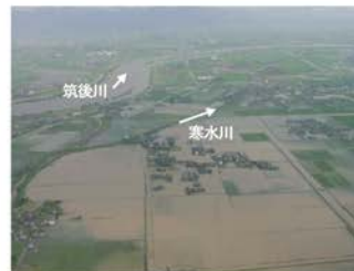
写真2-1-8 寒水川流域【みやき町田島】（平成13年7月）
