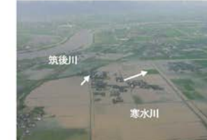
写真2-1-12 寒水川流域【みやき町田島】（平成13年7月）
