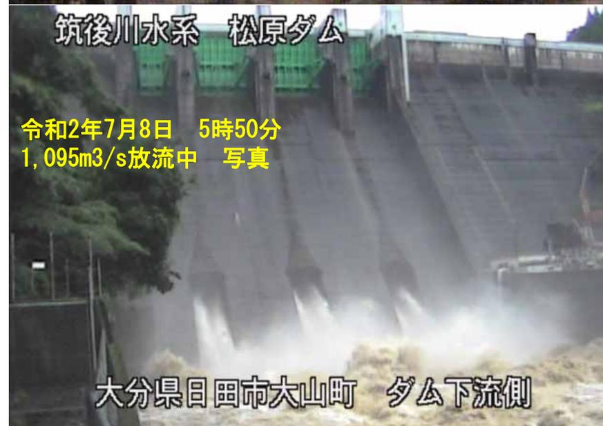
➤ S48.4のダム運用開始以来、初めて異常洪水時防災操作を行い、クレストゲートから放流。
