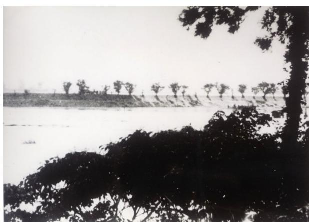
写真 1-2-5 堤防からの越水状況
