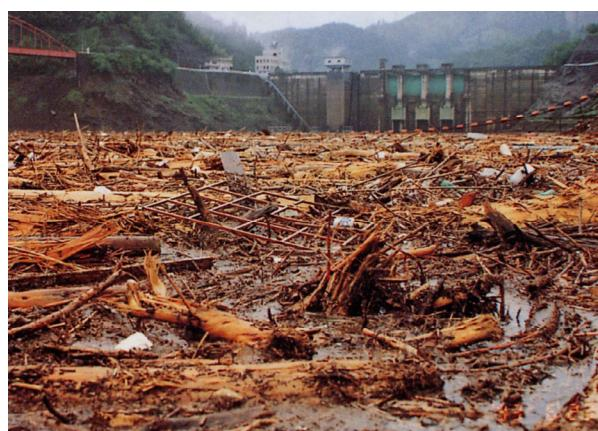
写真 1-2-22 松原ダム湖に流入した風倒木
