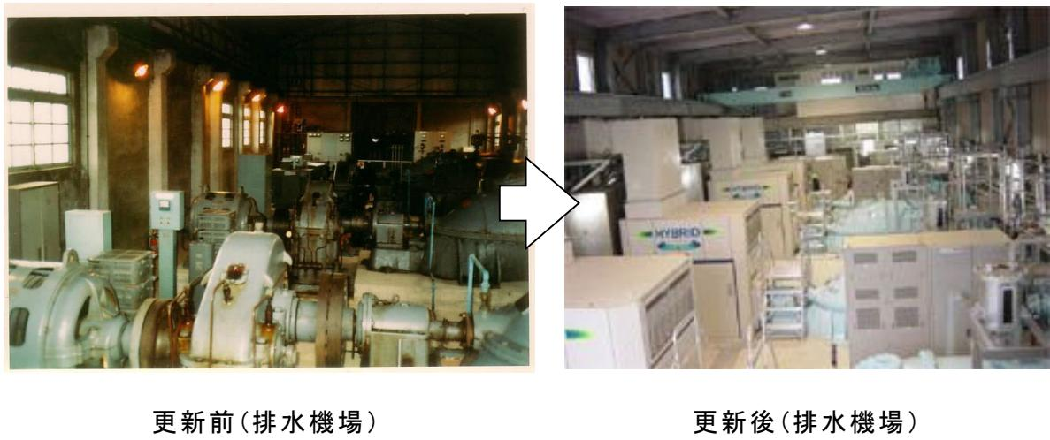
写真4-3-3 排水機場の施設更新による機能向上
