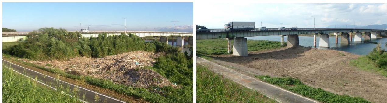
写真4-3-10 河道内の樹木の伐採及び塵芥処理前後(筑後川 両筑橋)
