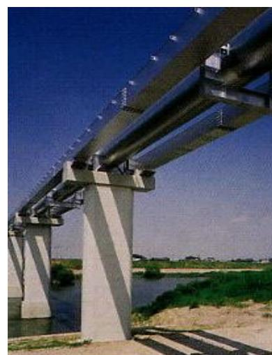
福岡導水の途中にある思案橋水管橋は、筑後川の水を福岡都市圏まで導水しています。
