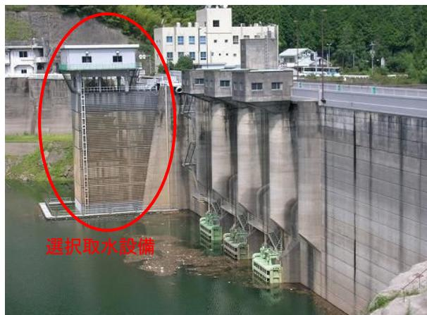
写真4-2-8 松原ダムの選択取水設備
