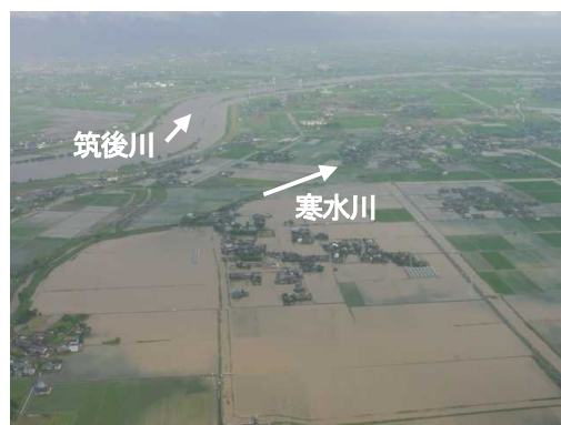
写真 2-1-1 4 寒水川流域[みやき町田島]（平成 13 年 7 月）
