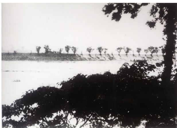
写真 1－2－5 堤防からの越水状況 (久留米市合川) (昭和 28 年 6 月洪水)
