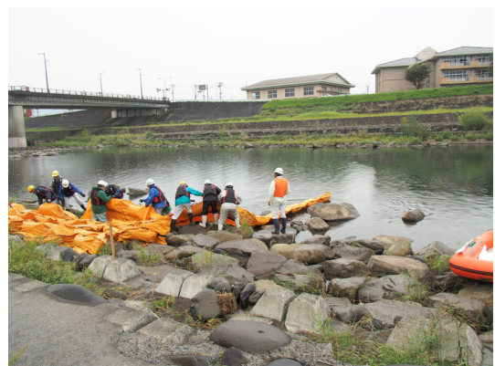
写真4-3-19 水質事故発生時の対応 水質事故発生時には、適切な箇所でオイルフェンスや吸着マットなどを設置し、下流への被害の拡大を防止します。
