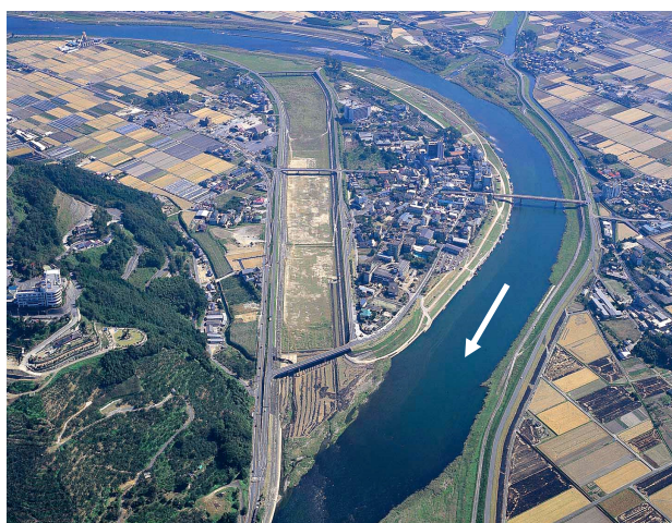
写真 1-2-17 原鶴分水路 (朝倉市)
