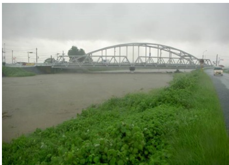
写真2-1-5 平成21年7月洪水（城原川：神崎市）
