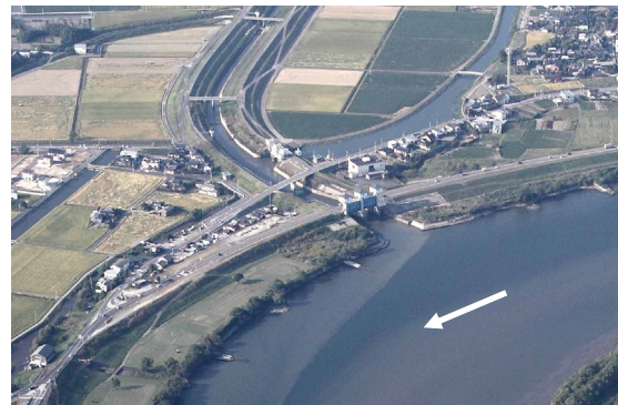
写真 1-2-26 寒水川水門 (みやき町)
