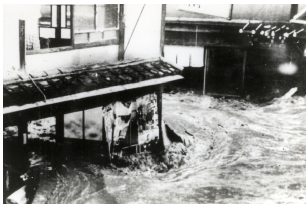
写真 1－2－1 濁流渦巻く日田市街地 (昭和 28 年 6 月洪水)
