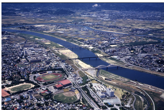
写真 1-2-12 小森野捷水路 (久留米市)
