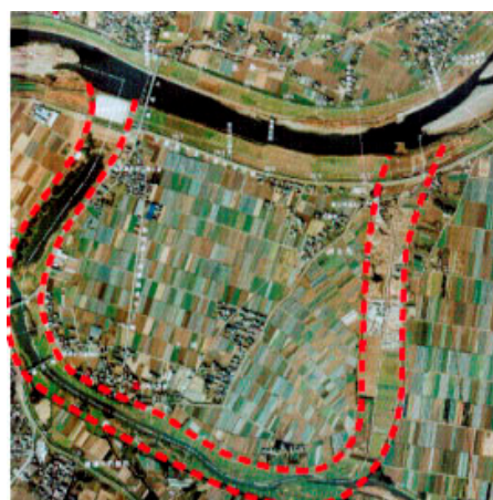
写真 1-2-13 金島捷水路 (久留米市)
