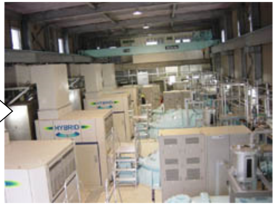
更新後（排水機場）
