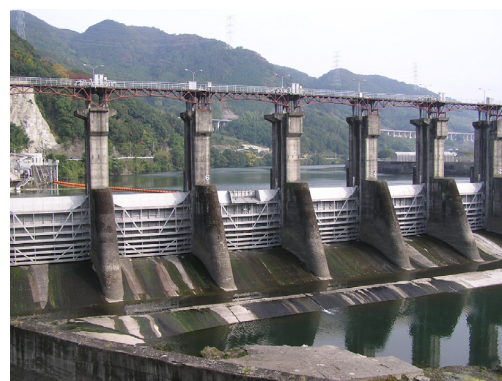
写真2-3-36 夜明ダム(日田市)
