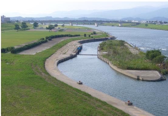
写真 4－3－15 小森野床固の閘門 (久留米市)
