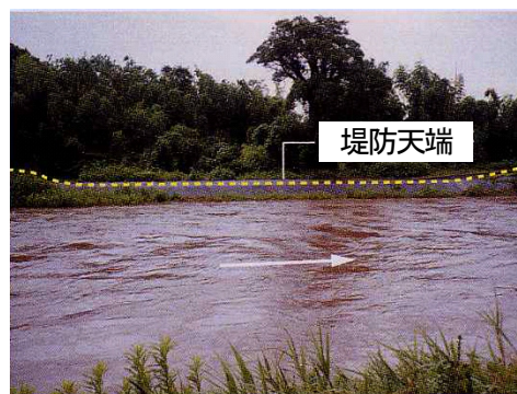
写真 2－1－4 堤防越水の危険な状況 平成 11 年 6 月洪水（城原川：神崎市）
