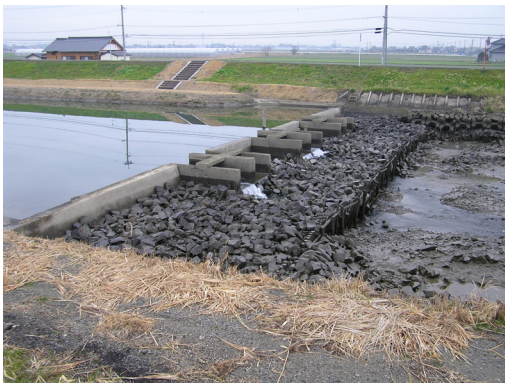
写真4-2-5 魚道のない堰(お茶屋堰: 城原川)
