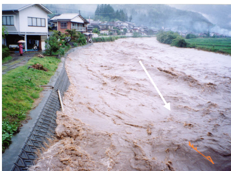
写真 2－1－1 河道内を満水状態で流下 平成 7 年 7 月洪水（花月川：日田市）
