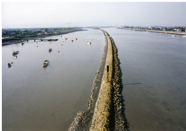
写真 1-2-1 1 デ・レーケ導流堤
