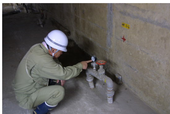
写真4-3-2 ダム等施設の点検
