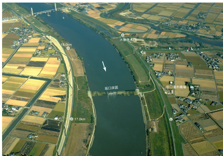
写真4-2-4 坂口床固付近(みやき町)
