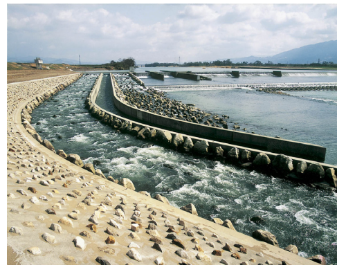
写真4-2-6 魚道のある堰(恵利堰: 筑後川)
