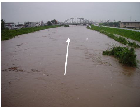
写真 2－1－3 河道内を満水状態で流下 平成 15 年 7 月洪水（城原川：神崎市）
