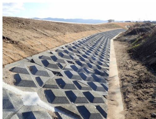
写真 2-1-21 危機管理型ハード対策実施箇所（三井郡大刀洗町）
