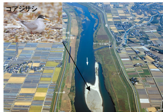
写真4-2-3 両筑橋上流付近(久留米市、朝倉市)
