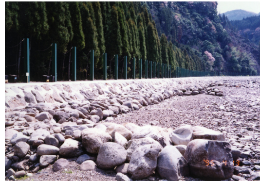
写真 1-2-24 風倒木流入防止柵（日田市）
