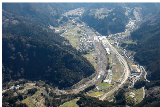
写真2-3-1 筑後川上流部(89km 付近)
