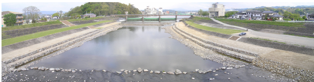
写真 5-4-4 整備後の隈川（日田市）
