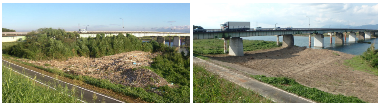
写真4-3-10 河道内の樹木の伐採及び塵芥処理伐採前後(筑後川 両筑橋)
