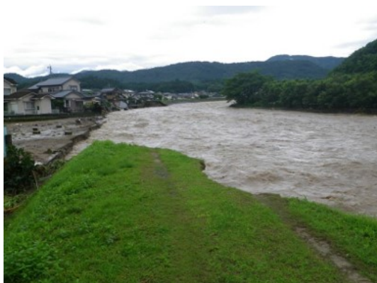
写真 1-2-27 洪水により決壊した堤防 (日田市)
