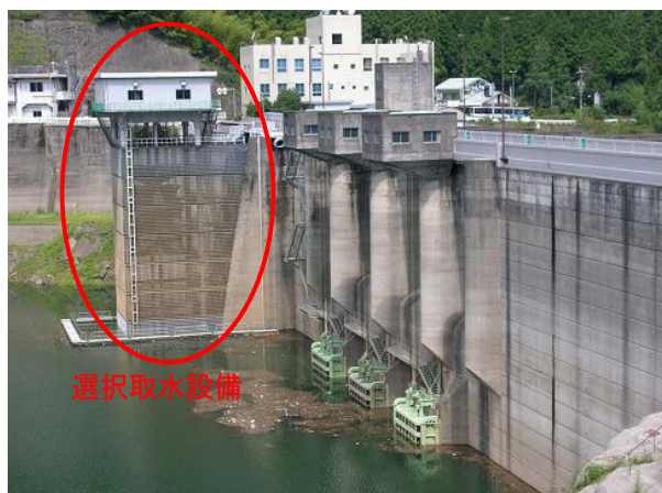
写真 4-2-8 松原ダムの選択取水設備
