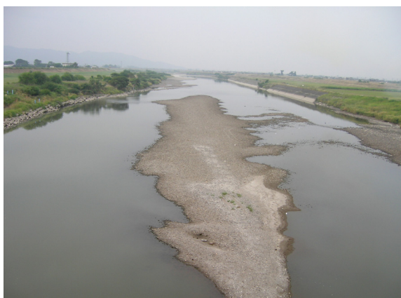
写真2-2-1 筑後川橋下流付近 (平成17年6月22日)
