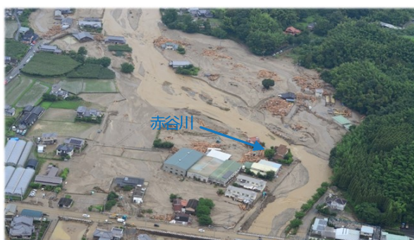
写真 1-2-29 平成 29 年 7 月出水により被災した赤谷川 (朝倉市)
