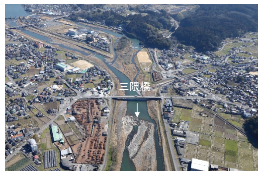
写真2-3-2 筑後川上流部(73km 付近)
