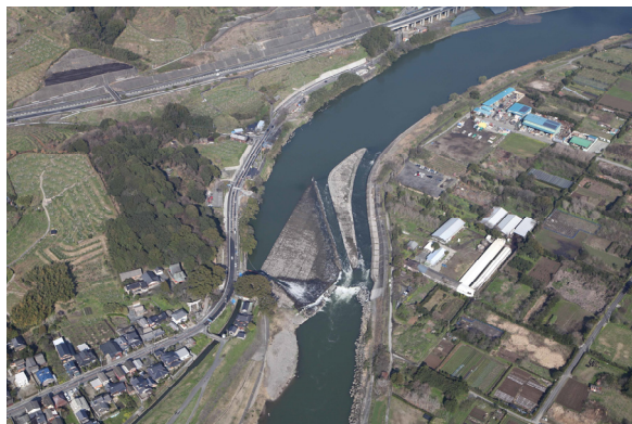
写真1-3-1 山田堰（筑後川53k200付近）
