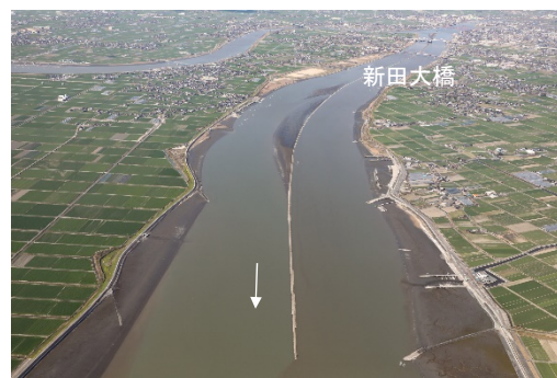
写真2-3-25 筑後川下流部(1km 付近)
