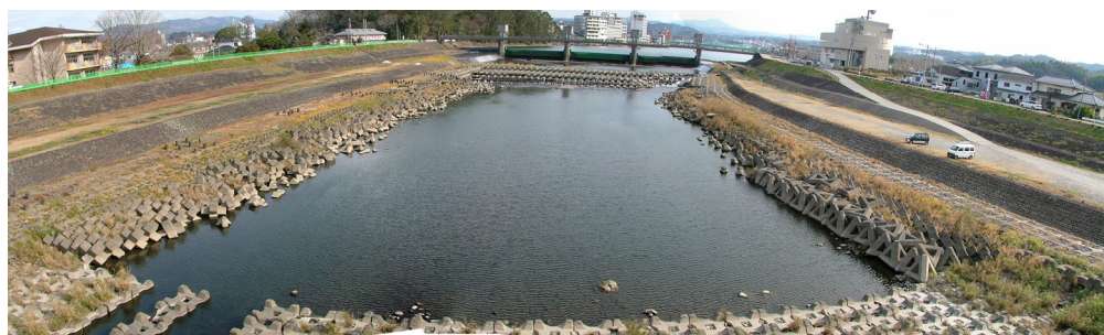
写真 5-4-3 整備前の隈川（日田市）
