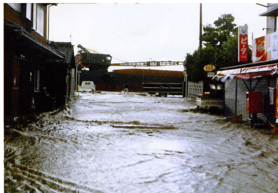
写真 1-2-20 昭和 60 年 台風 13 号による高潮の被害（大川市）
