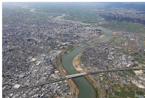
写真 1-1-6 久留米市周辺（筑後川大橋付近）
