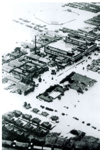
写真 1－2－4 水没した久留米市街地 (久留米医大付近：昭和 28 年 6 月洪水)
