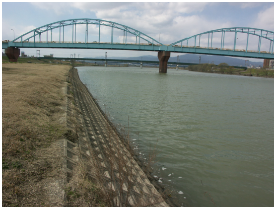
写真4-2-9 宮ノ陣橋上流付近の河岸 (久留米市)
