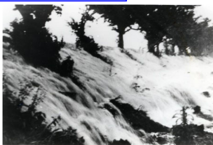
久留米市東櫛原の堤防からの越水状況
