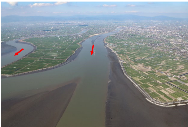
下流部(河口付近)
