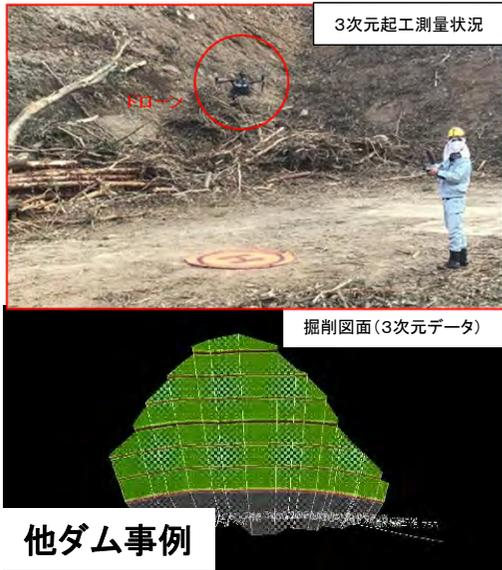
付替道路の施工にあたり、UAVを用いた3次元起工測量を実施することにより、測量の簡略化が可能となり、作業効率が向上する。また測量データをGPS搭載バックホウに読み込ませることで、丁張り設置等の期間が短縮され、工期短縮に繋がる。
