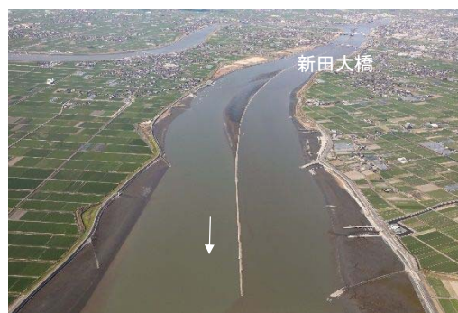
写真2-3-25 筑後川下流部(1km 付近)
