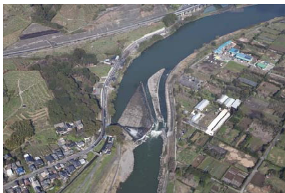
写真1-3-1 山田堰（筑後川53k200付近）
