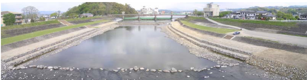
写真5-4-4 整備後の隈川（日田市）
