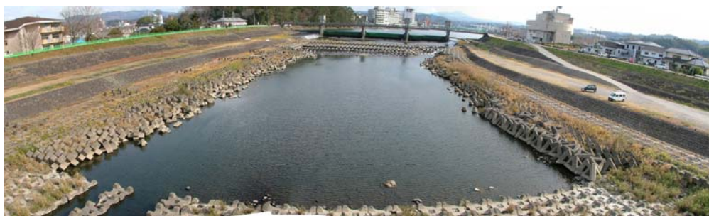
写真5-4-3 整備前の隈川（日田市）
