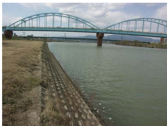
写真4-2-9 宮ノ陣橋上流付近の河岸 (久留米市)
