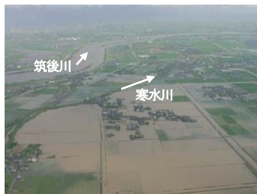
写真 2-1-1 4 寒水川流域[みやき町田島] (平成 13 年 7 月)
