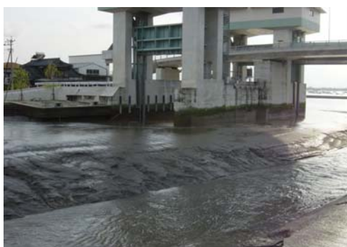
写真4-3-7 ガタ土の堆積状況 (花宗水門)
