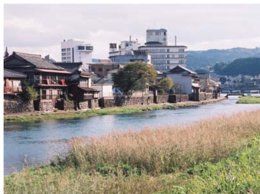
写真 4-2-1 2 庄手川沿いの建物 (日田市)
