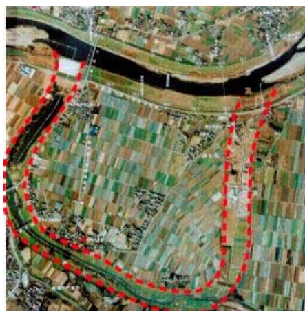
写真 1-2-13 金島捷水路 (久留米市)
