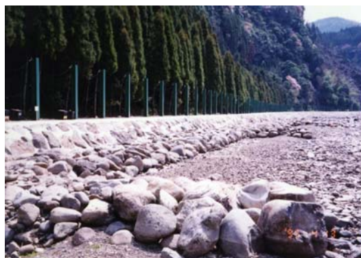
写真 1-2-24 風倒木流入防止柵（日田市）
