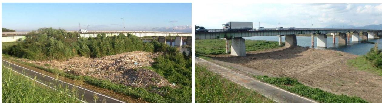
写真4-3-10 河道内の樹木の伐採及び塵芥処理伐採前後(筑後川 両筑橋) 河道内において樹木が繁茂し治水上支障をきたしているため、伐採し適切な維持管理に努めています。
