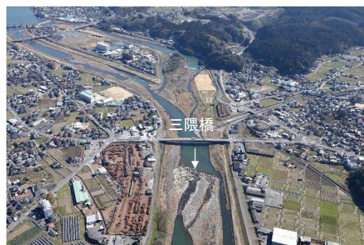
写真2-3-2 筑後川上流部(73km 付近)
