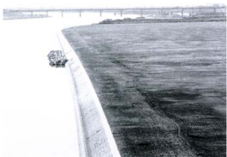
写真 2-3-38 高水敷整地及びコンクリート護岸等による ミヤイリガイの駆除（昭和 57 年頃）
