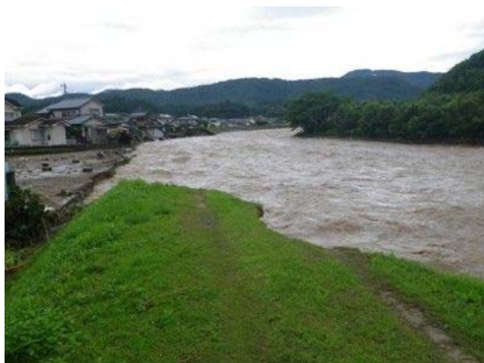
写真 1-2-27 洪水により決壊した堤防 (日田市)
