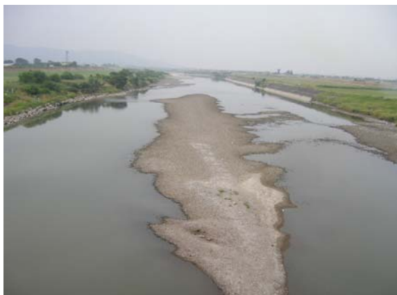
写真2-2-1 筑後川橋下流付近 (平成17年6月22日)
