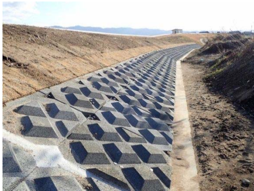
写真 2-1-21 危機管理型ハード対策実施箇所（三井郡大刀洗町）
