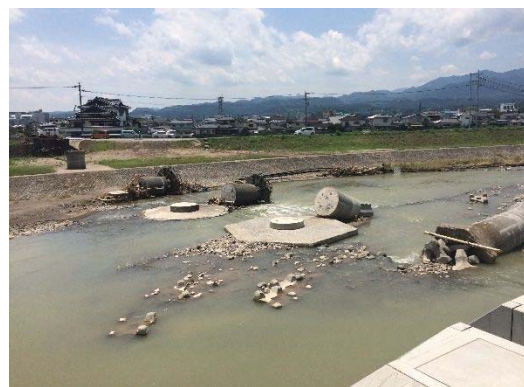
写真 1-2-28 倒壊した JR 鉄道橋 (日田市)
