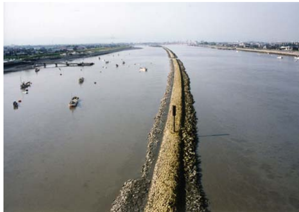
写真 1-2-11 デ・レーケ導流堤
