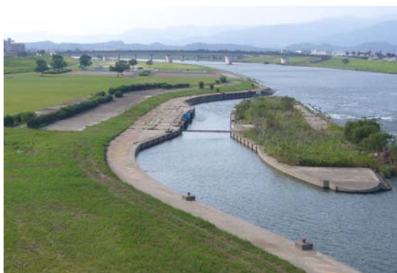
写真4-3-15 小森野床固の閘門 (久留米市)
