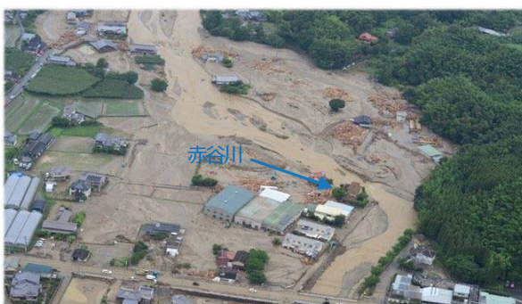
写真 1-2-29 平成 29 年 7 月九州北部豪雨により被災した赤谷川 (朝倉市)
