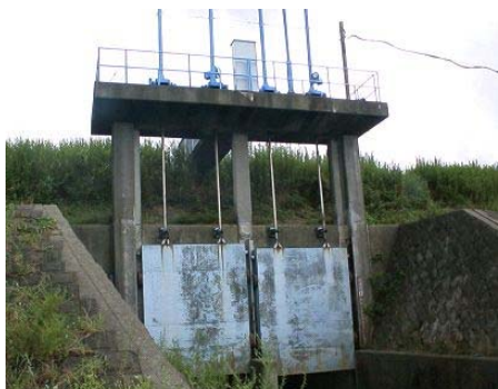
写真 2-1-2 2 老朽化した河川管理施設（樋門）
