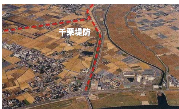
写真1-2-7 千栗堤防(三養基郡みやき町) 洪水から佐賀藩の領地を守るため、成富兵庫茂安によって築られました。
