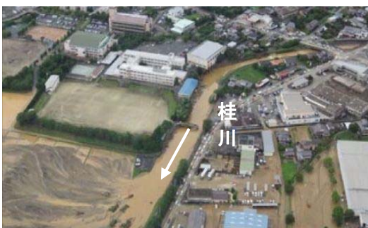
写真 2-1-1 5 桂川流域[朝倉市比良松] (平成 29 年 7 月)
