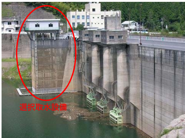
写真 4-2-8 松原ダムの選択取水設備
