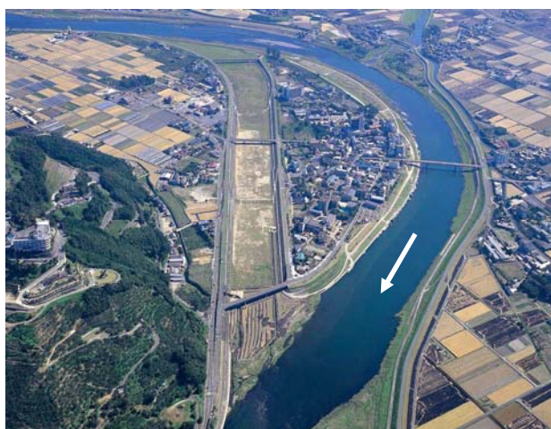
写真 1-2-17 原鶴分水路 (朝倉市)
