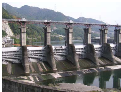
写真2-3-36 夜明ダム(日田市)
