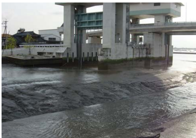
写真 2-1-24 河川管理施設周辺のガタ土堆積（花宗水門：大川市）
