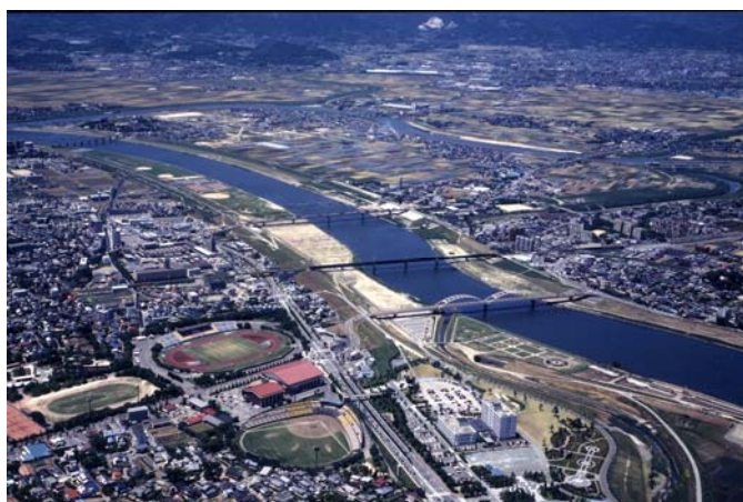
写真 1-2-12 小森野捷水路 (久留米市)
