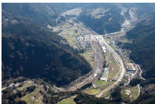
写真2-3-1 筑後川上流部(89km 付近)
