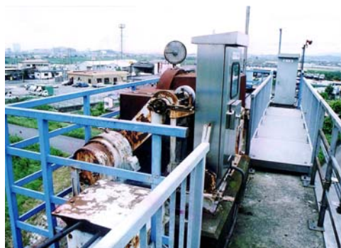
写真 2-1-2 3 老朽化した河川管理施設（開閉機）
