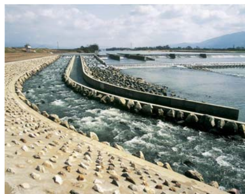
写真4-2-6 魚道のある堰(恵利堰:筑後川)
