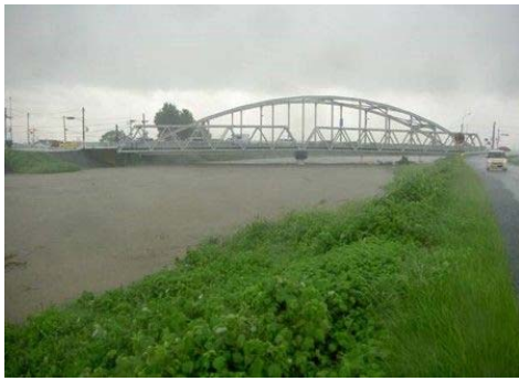
写真2-1-5 平成21年7月洪水（城原川：神崎市）
