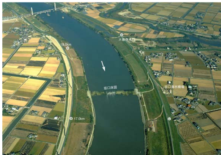
写真4-2-4 坂口床固付近(みやき町)
