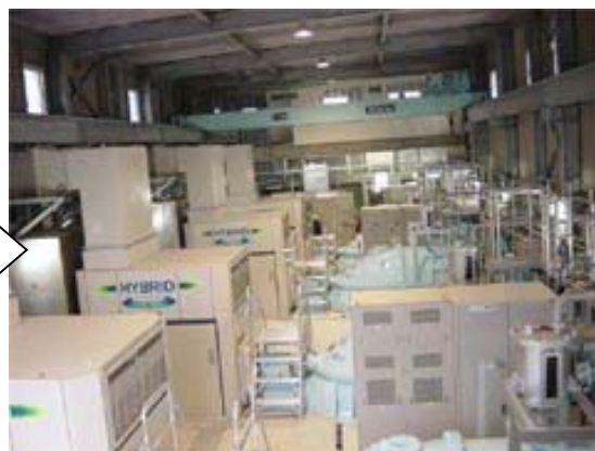
更新後(排水機場)
