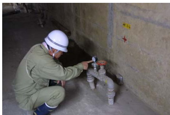
写真4-3-2 ダム等施設の点検
