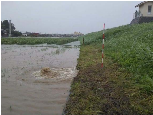
写真 2-1-20 久留米市北野町において発生した自噴 (令和 2 年 7 月)
