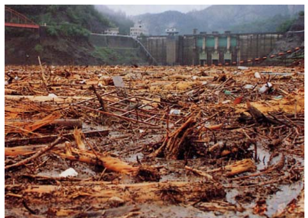
写真1-2-22 松原ダム湖に流入した風倒木 (平成5年6月洪水)
