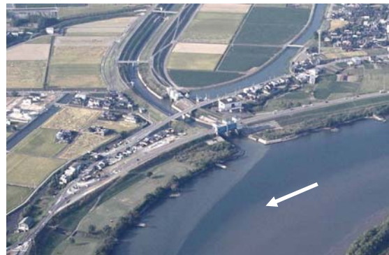
写真 1-2-26 寒水川水門 (みやき町)
