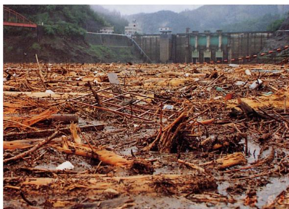
写真1-2-22 松原ダム湖に流入した風倒木
