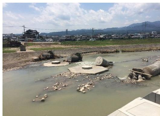
写真 1-2-28 倒壊した JR 鉄道橋
