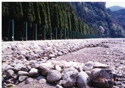
写真 1-2-24 風倒木流入防止柵（日田市）
