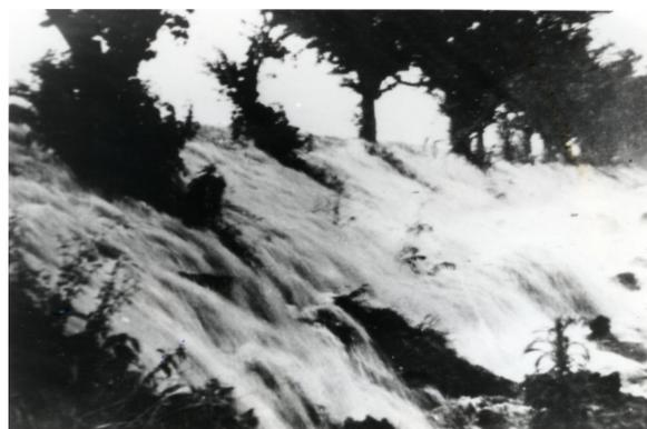
写真1-2-6 堤防からの越水状況
