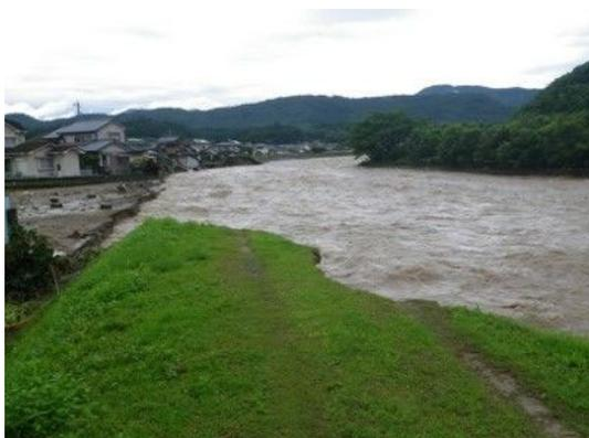
写真 1-2-27 洪水により決壊した堤防
