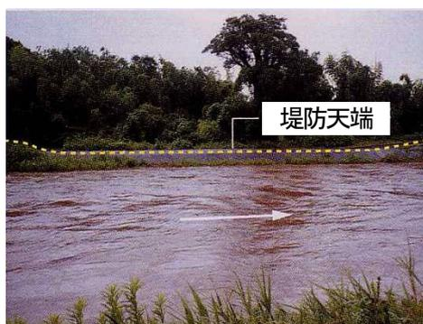
写真 2-1-4 堤防越水の危険な状況
