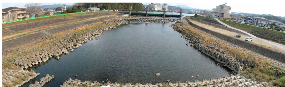
写真 5-4-3 整備前の隈川（日田市）
