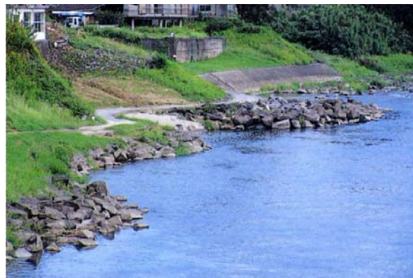
写真1-2-10 水刳（朝倉市杷木町） 洪水の流れを変えることで、河岸防護や流路制御を目的として設置されました。
