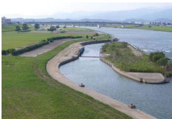
写真 4－3－15 小森野床固の閘門 (久留米市)
