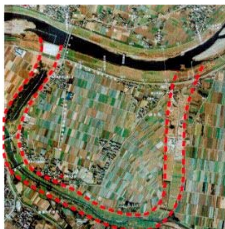
写真 1-2-13 金島捷水路 (久留米市)
