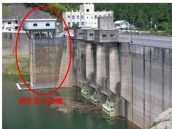
写真 4-2-8 松原ダムの選択取水設備
