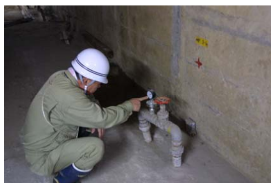
写真4-3-2 ダム等施設の点検
