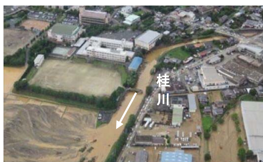
写真 2-1-1 5 桂川流域[朝倉市比良松]（平成 29 年 7 月）
