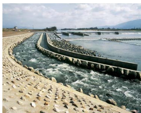
写真4-2-6 魚道のある堰（恵利堰：筑後川）
