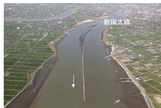
写真2-3-25 筑後川下流部(1km 付近)
