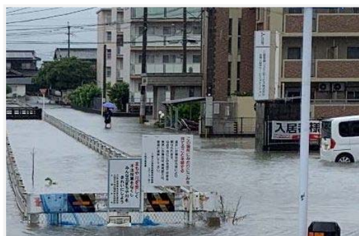
写真 2-1-1 7 下弓削川流域[久留米市東合川]（令和 3 年 8 月）
