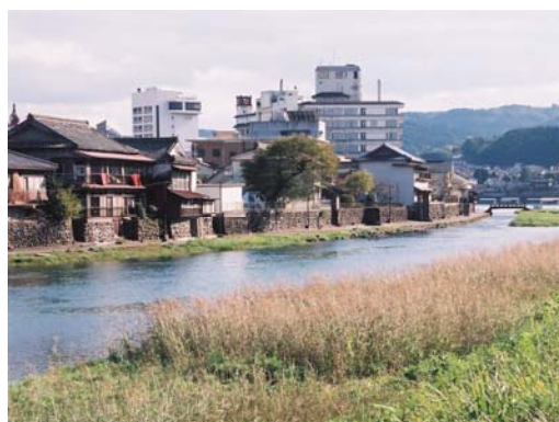
写真 4－2－1 2 庄手川沿いの建物（日田市）
