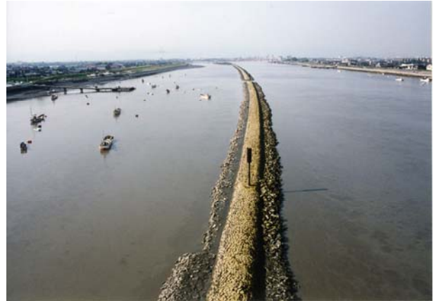
写真 1-2-11 デ・レーケ導流堤
