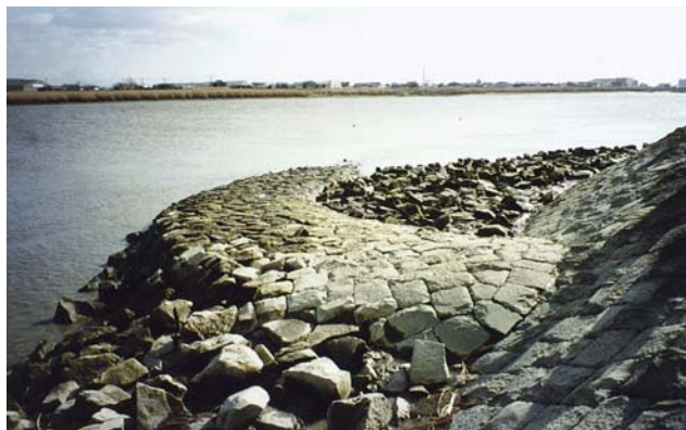
写真1-2-9 荒籠（大川市道海島） 河岸防護のほか、舟運のための水深の確保、河岸への昇降等、多目的で設置されました。
