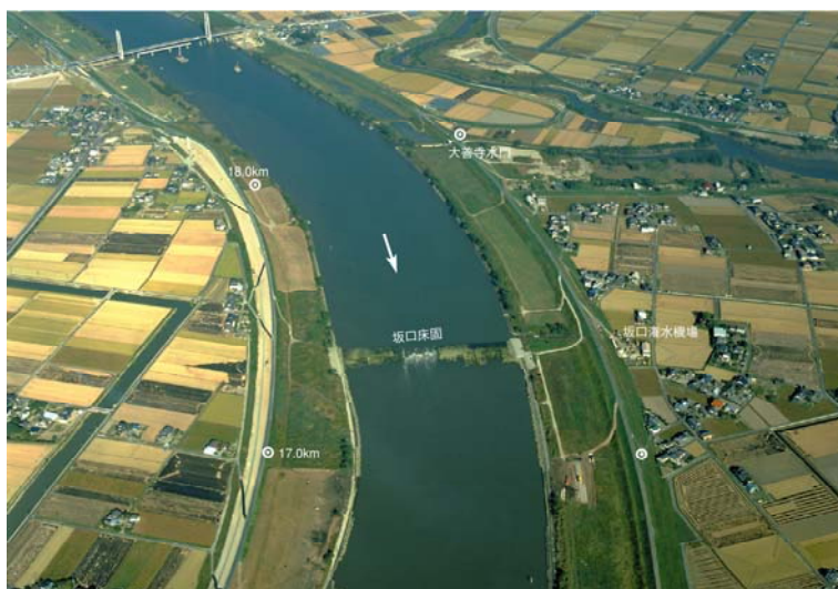
写真4-2-4 坂口床固付近(みやき町)
