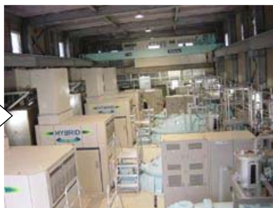
更新後（排水機場）
