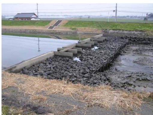
写真4-2-5 魚道のない堰（お茶屋堰：城原川）
