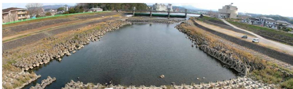
写真 5-4-3 整備前の隈川（日田市）
