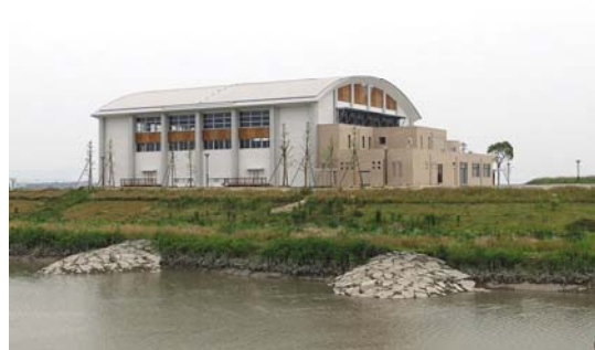
写真 4-3-14 久留米西部河川防災ステーション(久留米市)
