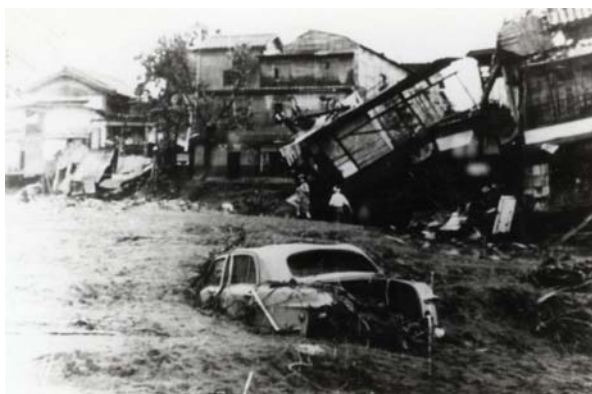
写真 1－2－3 大きな被害を受けた 原鶴温泉街 (昭和 28 年 6 月洪水)
