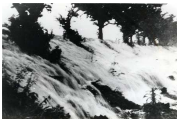
写真 1－2－6 堤防からの越水状況 (久留米市東榎原) (昭和 28 年 6 月洪水)
