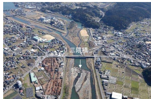
写真2-3-2 筑後川上流部(73km 付近)
