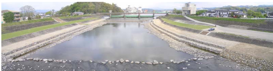
写真 5-4-4 整備後の隈川（日田市）
