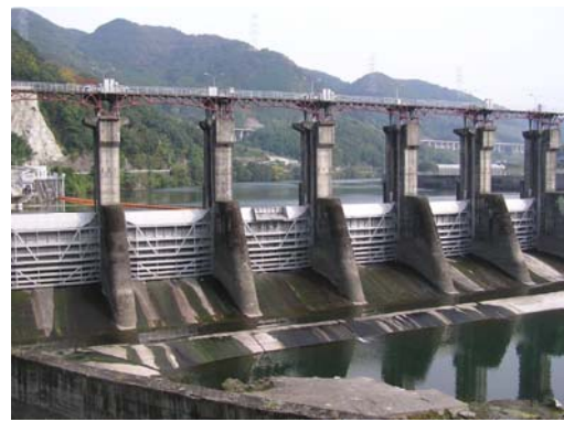
写真2-3-36 夜明ダム(日田市)
