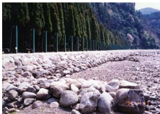
写真 1-2-24 風倒木流入防止柵（日田市）
