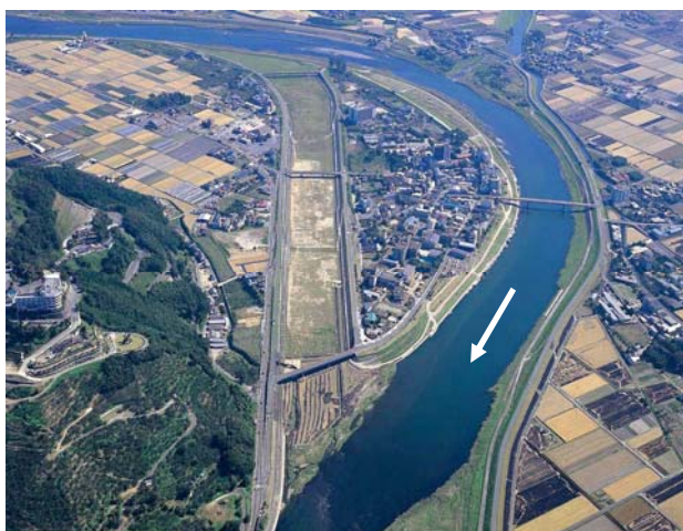
写真 1-2-17 原鶴分水路 (朝倉市)
