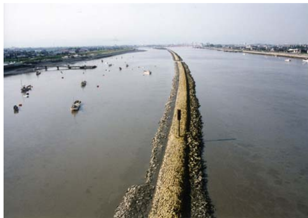
写真 1-2-1 1 デ・レーケ導流堤
