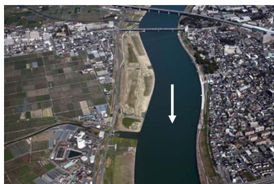
写真 1-2-25 久留米市街部の堤防整備（久留米市宮ノ陣町大杜）
