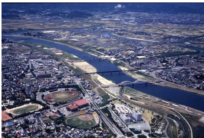
写真 1-2-12 小森野捷水路 (久留米市)
