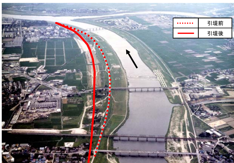
写真 1-2-16 久留米市東櫛原の引堤 (平成 4 年完成)
