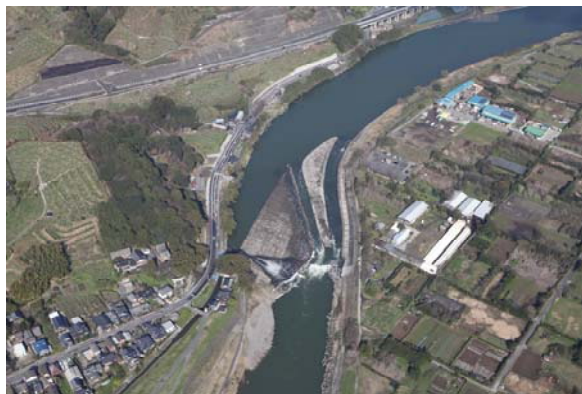
写真1-3-1 山田堰（筑後川53k200付近）
