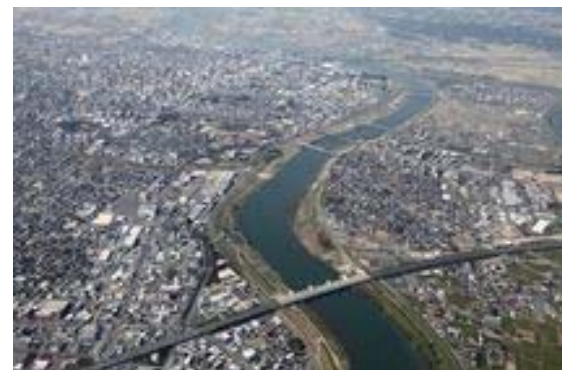
写真 1-1-6 久留米市周辺(筑後川大橋付近)
