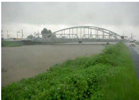
写真2-1-5 平成21年7月洪水（城原川：神崎市）
