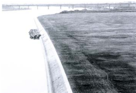
写真 2-3-19 高水敷整地及びコンクリート護岸等による ミヤイリガイの駆除（昭和 57 年頃）
