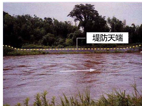
写真 2-1-4 堤防越水の危険な状況 平成 11 年 6 月洪水 (城原川：神崎市)
