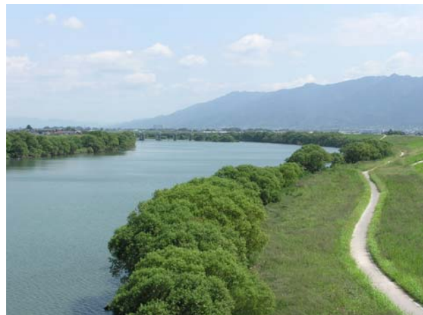
写真 2-1-20 河道内の樹木繁茂状況（久留米市）
