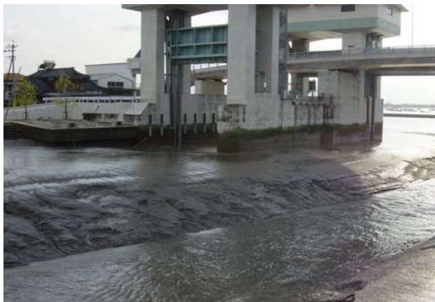
写真 2-1-19 河川管理施設周辺のカタ土堆積（花宗水門：大川市）
