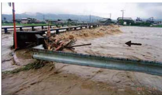
写真2-1-7 平成24年7月洪水（隈上川：うきは市）
