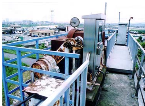
写真 2-1-18 老朽化した河川管理施設（開閉機）
