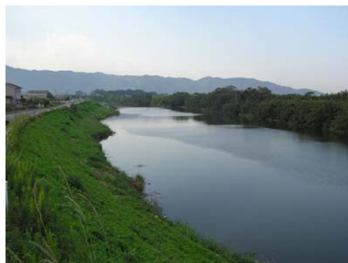
写真2-3-40 湖畔の緑と調和した鎮西湖（旧筑後川）
