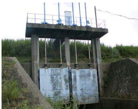
写真 2-1-17 老朽化した河川管理施設（樋門）
